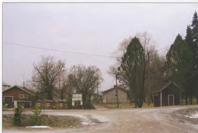
Uusien rakenteiden kuten kierrätysastioiden sijoittaminen onnistuneesti edellyttää asema-alueen ja asemapuiston rakenteen ymmärtämistä. Perniössä uusi tielinjaus on katkaissut asema-alueen ja tuonut jätteastiat sen keskelle. Mirkka Niemi 2004.
