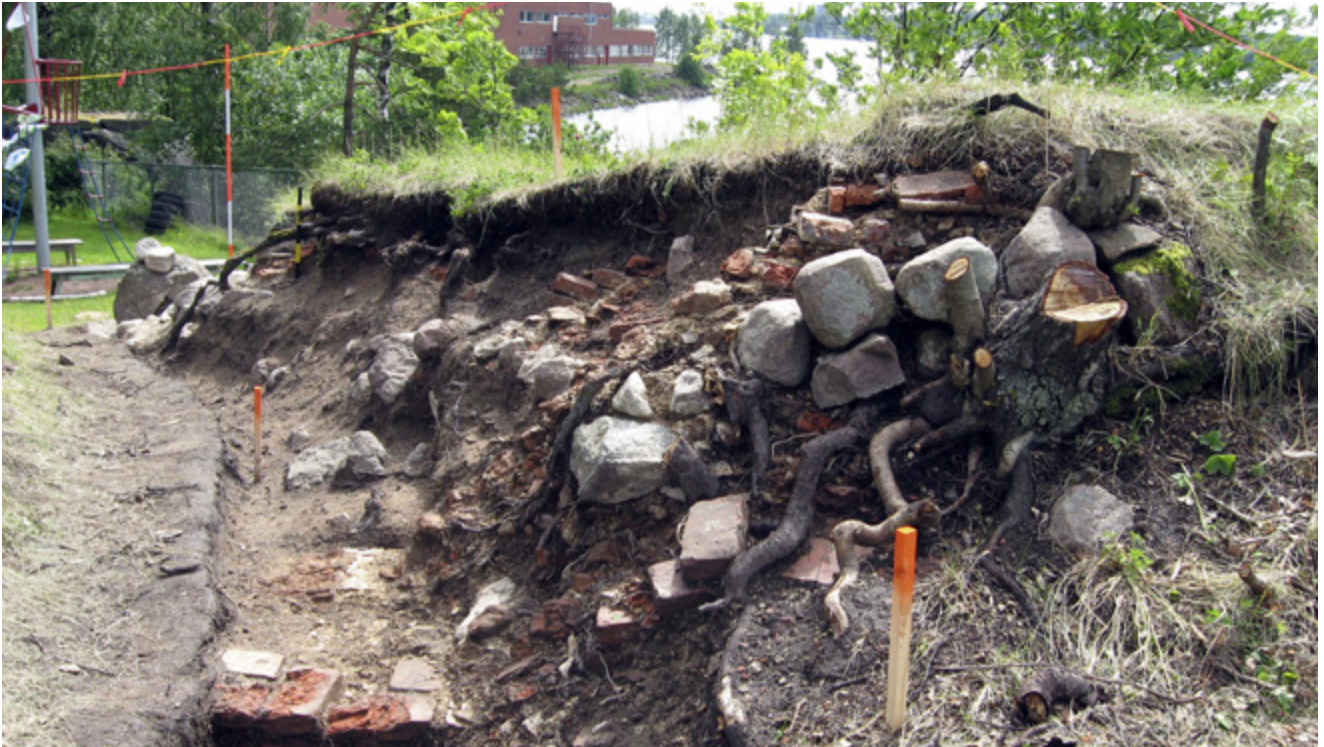
Kuva 10. Patteri n:o 3 vasemman kyljen lävitse kulkee syvään kaivettu ja tallattu polku. Kesällä 2008 patterin rakennetta tutkittiin ja dokumentoitiin mm. jo osittain tuhoutuneen vasemman siiven kohdalta. Kuva: M. Kykyri, Kymenlaakson museo.
