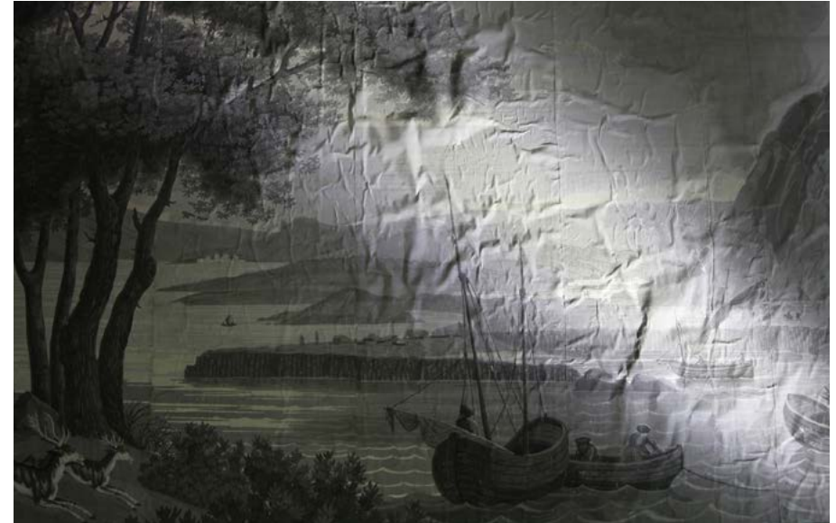
Huvimajan takaseinän tapettivuodot ennen konservointia. Rypyt ja venymät korostuvat sivuvalossa tarkasteltuina. Kuva Anna-Maria Kymäläinen, 2016, Museovirasto.
