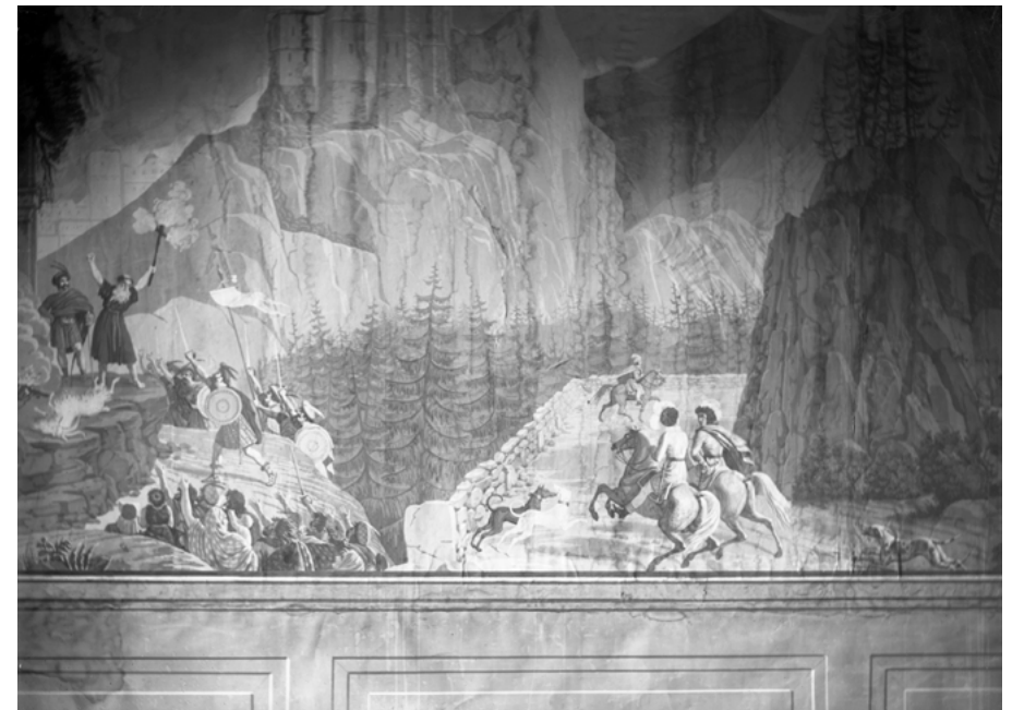
Huvimajan vasemmanpuoleisen seinän vuotia ja alaosan paperipaneelin yläreunaa 1900-luvun alkussa. Tapetissa on jo laajalti kosteusvaurioita, mutta osa liimamaalista on vielä kohtalaisen hyvässä kunnossa. Kuvaaja tuntematon, lasinegatiivi, Museoviraston kuvakokoelmat.
