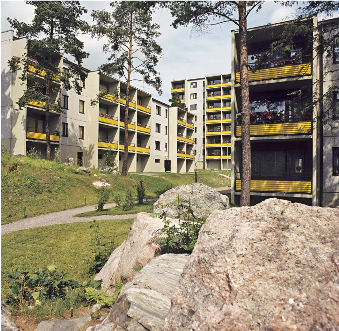
1970-luvun lähiö - Turun Uittamon kaupunginosan betonielementtirakenteisia kerrostaloja. Volker von Bonin / Museovirasto
