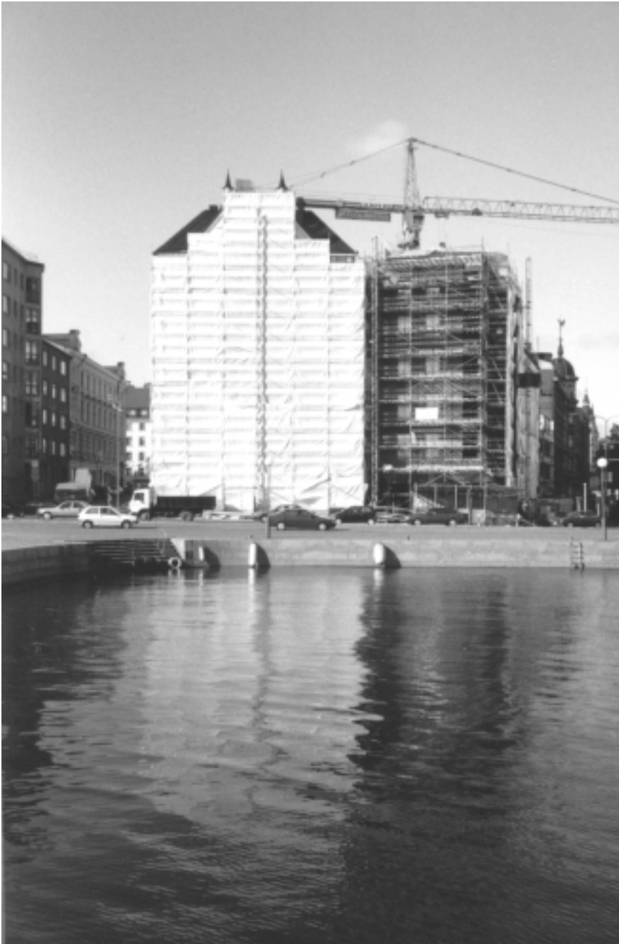
Kuva 7. Julkisivupintojen korjaustyöt tulee tehdä sääsuojatuilta telineiltä, näin taataan onnistunut lopputulos.
