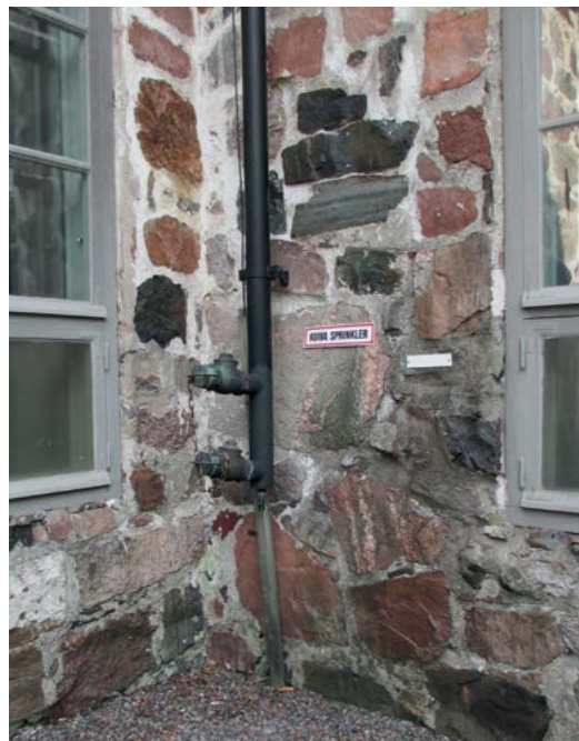
Sammutuslaitteiston palokunnan syöttöliitin. Lisävesi tuodaan pelastuslaitoksen yksiköllä.
