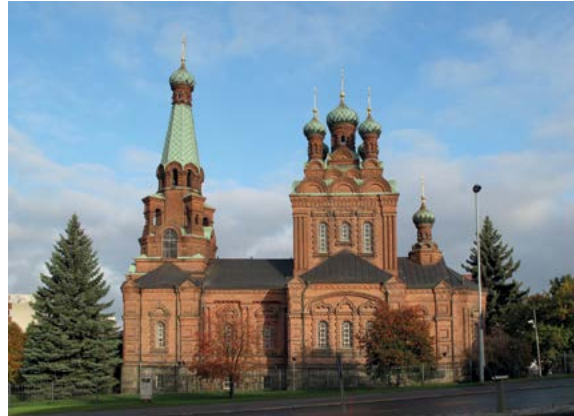
Tampereen Pyhien Aleksanteri Nevalaisen ja Nikolaos Ihmeidentekijän eklektinen, punatiilinen kirkko rakennettiin kaupunkikuvallisesti keskeiselle paikalle sotilasinööri, eversti T. U. Jazykovin laatimien piirustusten pohjalta 1896–1899.
