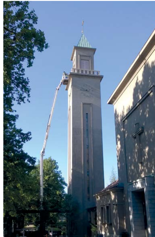
Rappauskorjauksia tehdään sekä nostureilla että sääsuojassa telineiltä. Kuvassa Helsingin Hietaniemen hautausmaan uuden kappelin rappauskorjaus 2014.
