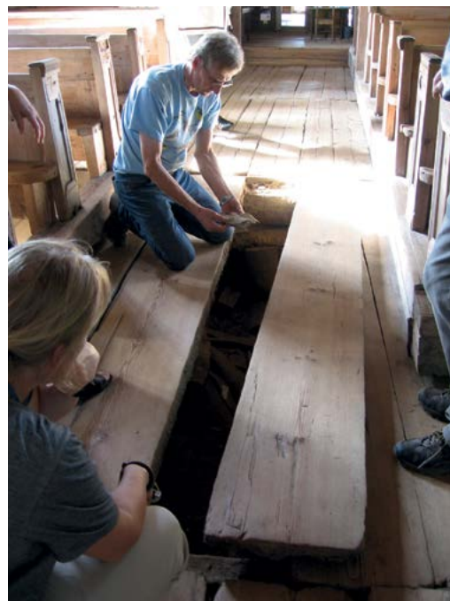
Petäjäveden vanhan kirkon lattian alustaa tarkkaillaan säännöllisesti.
