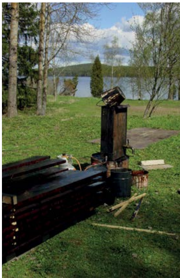
Tervaan kastettuja paanuja odottamassa katolle laittamista.
