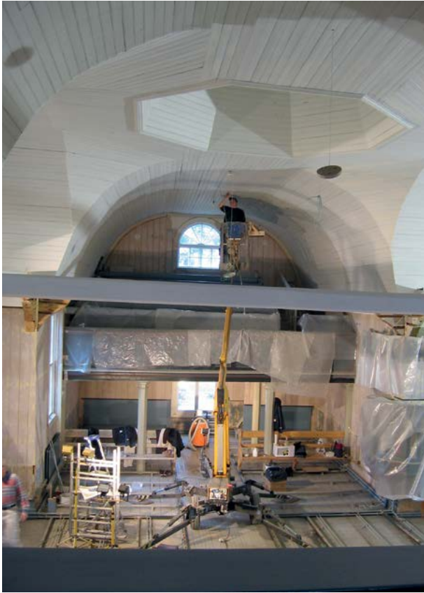
Dragsfjärdin kirkko työmaana 2008. Penkit joudutaan usein poistamaan korjaus- ja kunnostustöiden ajaksi. Paikoilleen jäävä kiinteä sisustus tulee suojata huolella ja tarkoituksenmukaisesti.
