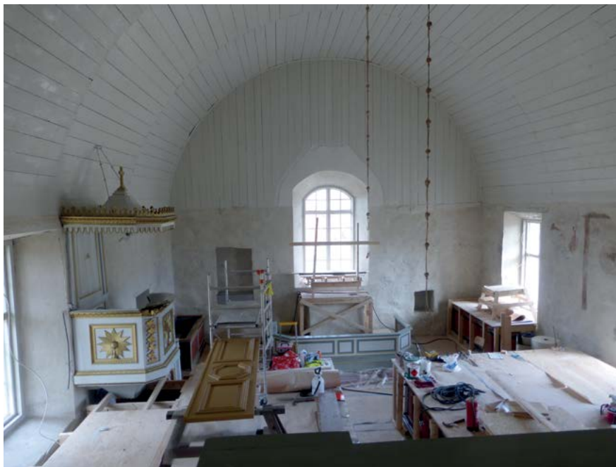
Geta kyrka på Åland i byggskedet 2017. Kyrkans bänkar och altare har skyddats väl inför renoveringsarbetet.
