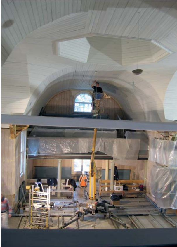
Byggplats vid Dragsfjärds kyrka 2008. Bänkarna måste ofta tas bort medan reparations- och renoveringsarbeten pågår. Fast inredning som står kvar ska skyddas omsorgsfullt och ändamålsenligt.
