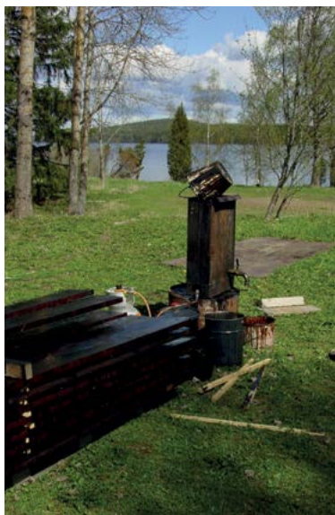
Tjärbestrukna spån väntar på att läggas ut på taket.
