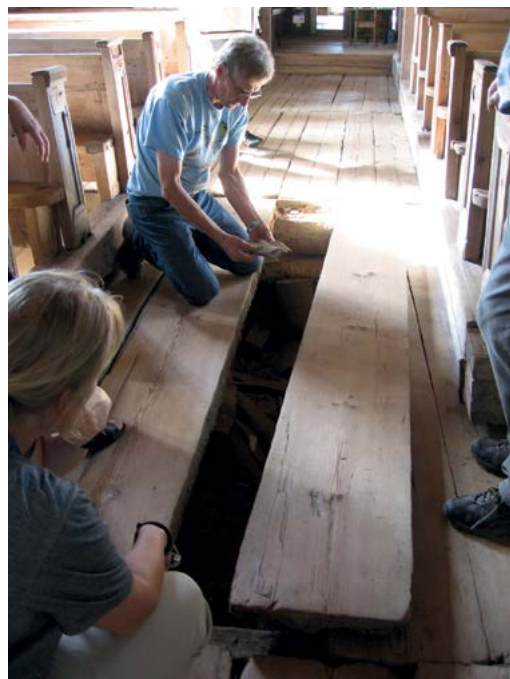
Underlaget till golvet i Petäjävesi gamla kyrka inspekteras regelbundet.
