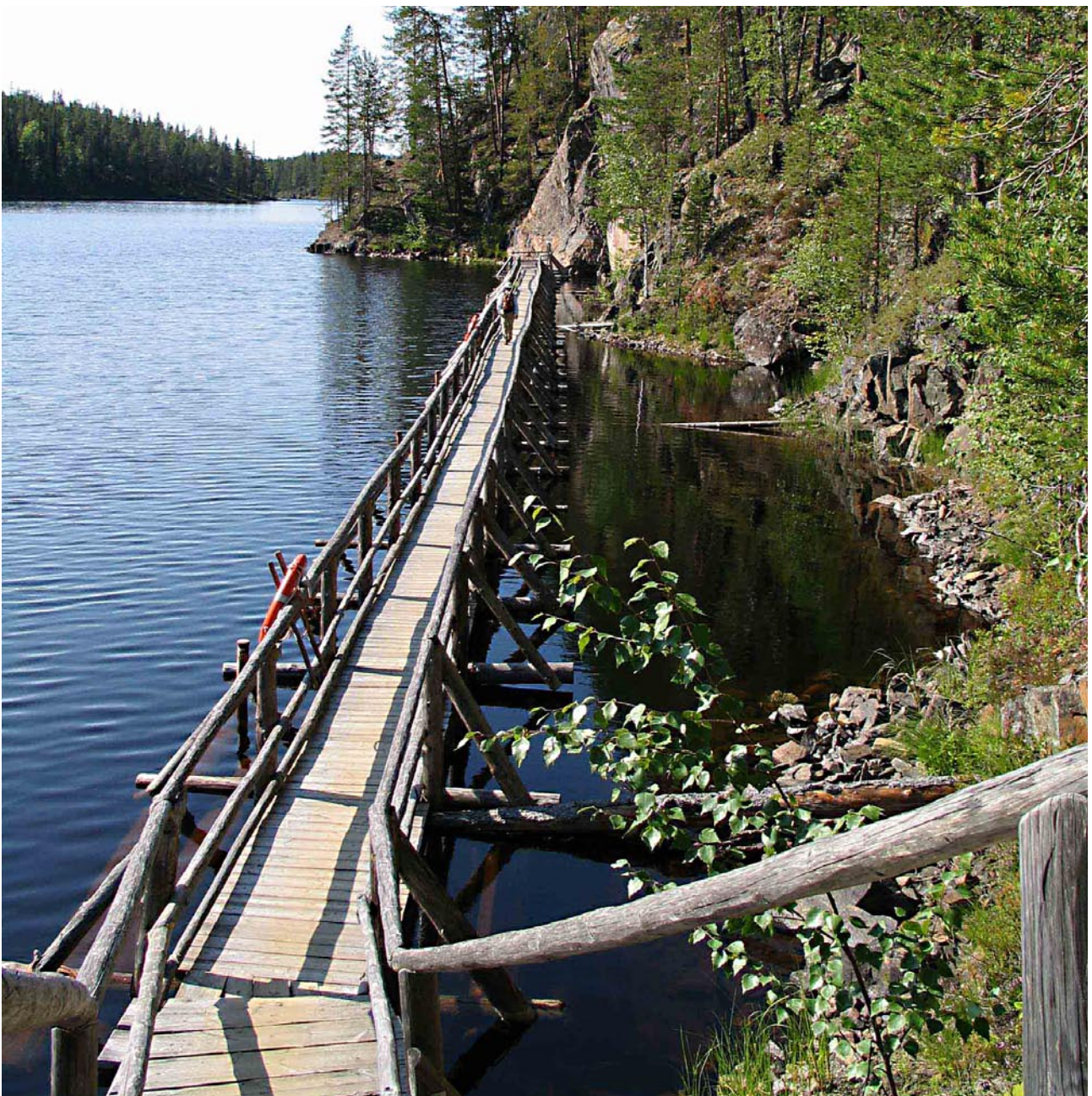
Suomussalmen Väräkallion kalliomaalauksille pääsyä on helpotettu kulkusillan avulla. Helena Taskinen, MV.
