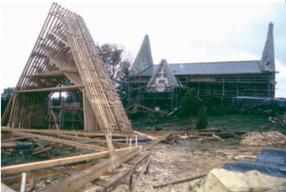
Tyrvään Pyhän Olavin kirkon rauniot suojattiin palon jälkeen.
