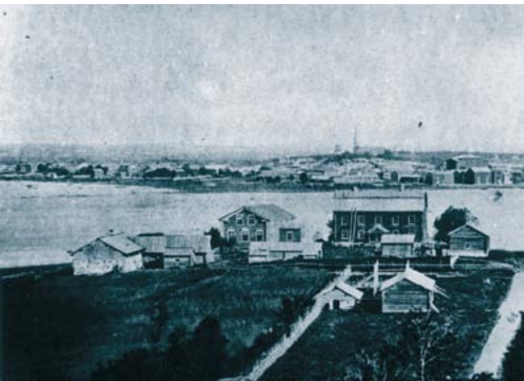
Alatornion pappila 1890-luvulla. Kuvassa näkyvät rakennukset vastaavat lukumääräisesti vuoden 1832 inventarioluetteloa. Kuva Tornionlaakson maakuntamuseo, kuvaaja tuntematon.
