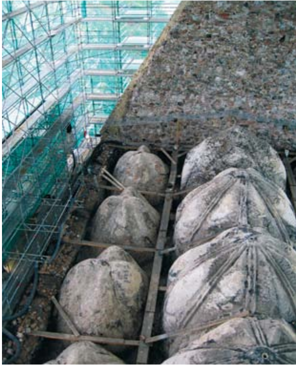
Porvoon keskiaikaisen kirkon palon jälkeisissä kattamistöissä tyhjennettiin holvien väliset syvennykset, jotka oli täytetty hiekalla ja vanhalla rakennusjätteellä. Kuva Elisa Heikkilä, Museovirasto.
