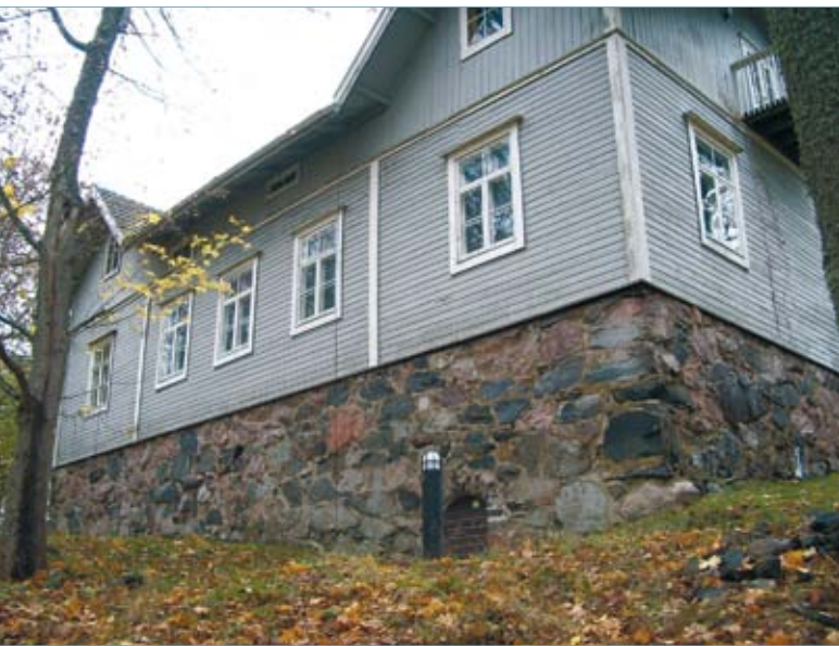
Pohjan Gennäsin myöhäiskeskiaikaisesta kartanolinnasta on jäljellä holvattu kellarikerros, jonka päälle on myöhemmin rakennettu puinen päärakennus. Kuva Marianna Niukkanen, Museovirasto.
