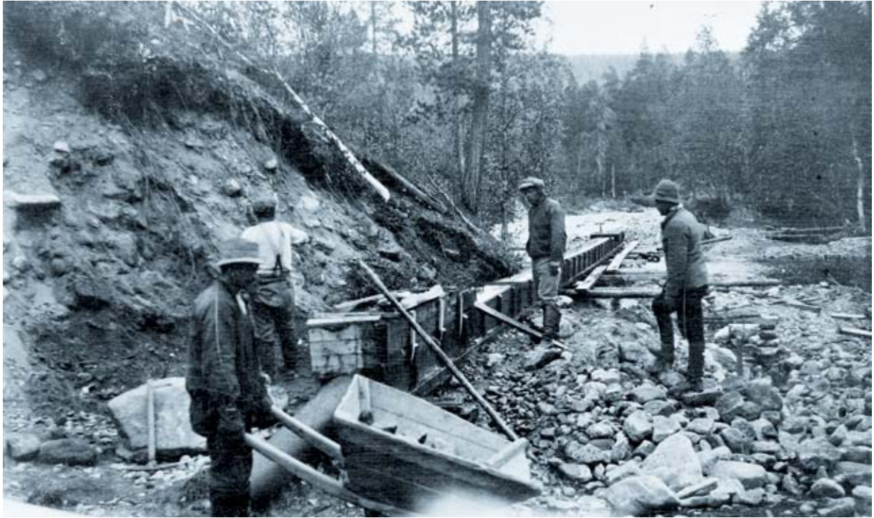
Kullankaivajia Inarin Palsinojalla vuonna 1923. Kuva-alan eteen on tehty pato ja maa-ainesta lapioidaan ränniin. Kuva R. Rehn, Museoviraston kuva-arkisto.
