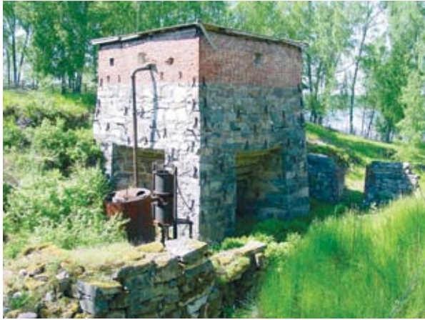
Hankoniemellä sijaitsevan Skogbyn ruukin masuunin raunio hahmottuu toiminnallisena kokonaisuutena. Säilyneisiin yksityiskohtiin kuuluu vuonna 1856 asennettu puhalluslaite. Kuva Timo Kantonen, Museovirasto.
