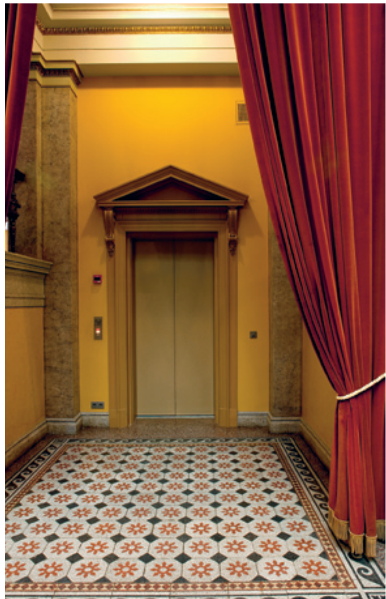
Hissen i anslutning till den tillgängliga rutten i Ständerhuset passar den värdefulla interiören. Foto Museiverket / Soile Tirilä.
