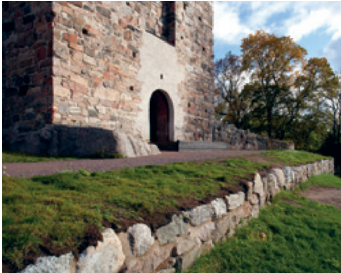
Muren och marken framför det västra tornet höjdes en halv meter så att rampen blev tillräckligt flack. De slutgiltiga höjningarna fastställdes först i byggskedet. Foto Museiverket / Soile Tirilä.
