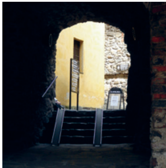
Trappan och de rännformade flyttbara ramperna som används idag. Foto Tröskeln rf / Niina Kilpelä.
