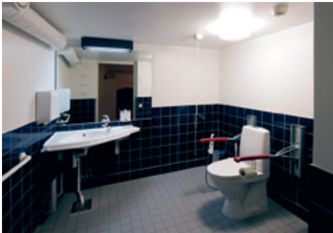
Den tillgängliga toaletten som byggdes i Åbo slott 2010. Den mörka nedre delen gör det enklare att urskilja de ljusa möblerna. Handduschen är placerad vid toalettstolens armstöd så att den enkelt kan nås. Foto Museiverket / Soile Tirilä.
