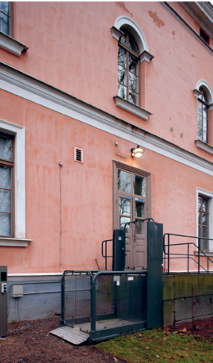
Lyftanordningen som monterats på trappan till Villa Hagasund utmärker sig som en ny teknisk anordning. Foto Museiverket / Soile Tirilä.
