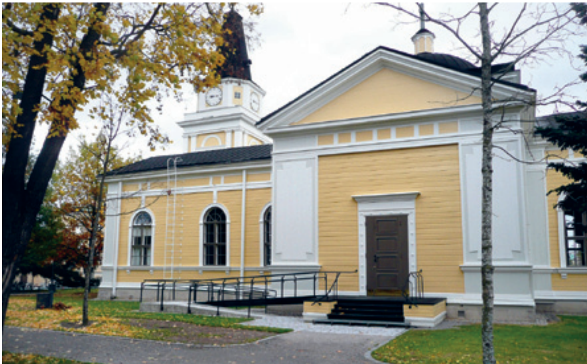
Rampens nedre del gjordes av granit och betong, den övre delen tillverkades som en bro med stålkonstruktioner. Trappavsatsen av trä byggdes om så att den blev djupare. Foto Hanna Lyytinen.
