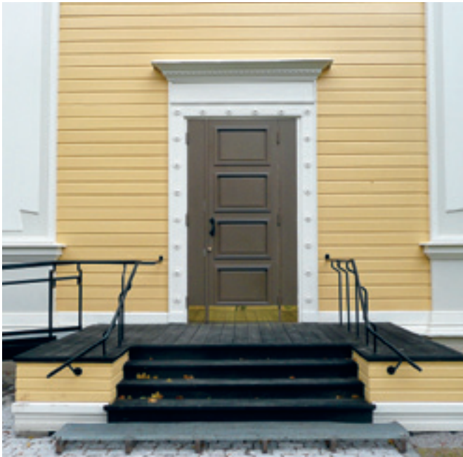
Dörröppningens ursprungliga bredd bevarades visuellt, även om dörren byttes ut mot en smalare som är enklare att öppna. Foto Hanna Lyytinen.
