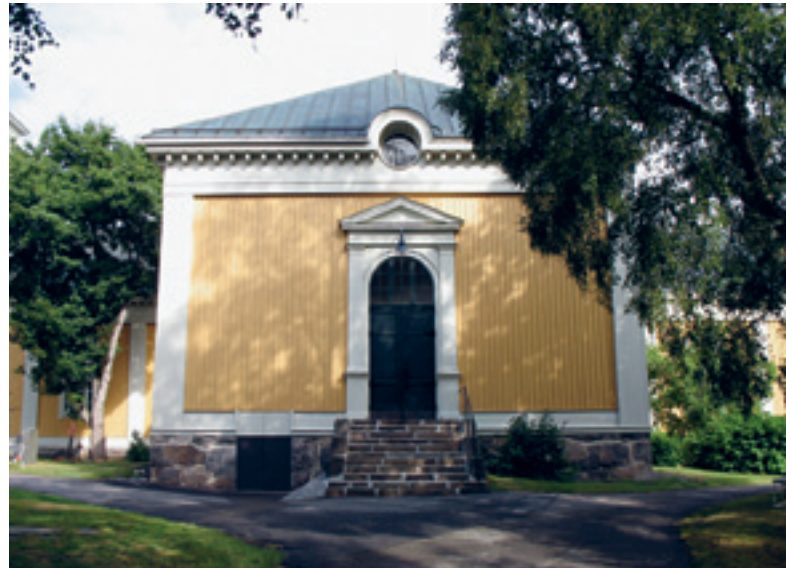
I Laihela kyrka monterade man en dörr på stenfoten och bakom dörren en hiss som går till det stora vindfånget ovanför stenfoten. Foto Museiverket / Maria Kurtén.
