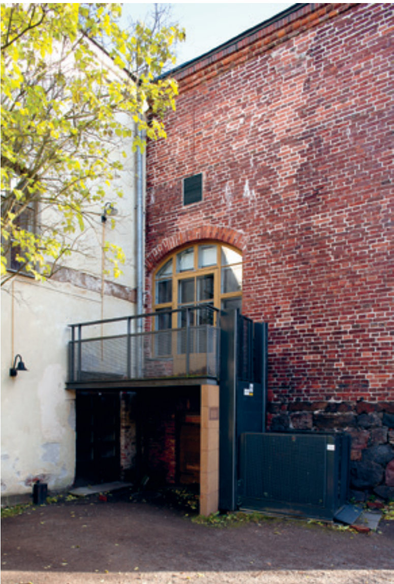
Lyftanordningen till Tenalji von Fersen på Sveaborg. Foto Museiverket / Soile Tirilä.
