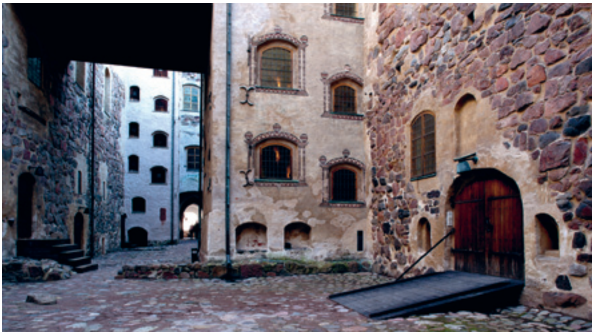
På grund av objektets kulturhistoriska värde uppfyller alla lösningar inte dagens bestämmelser fullt ut och man behöver en assistent längs rutten. Man har kommit överens om avvikelserna med byggnadstillsynen och tillgänglighetsombudet Heikki Haulisto. Foto Museiverket / Soile Tirilä.
