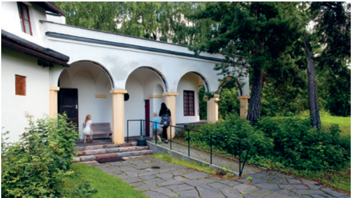
Rampen vid museet i Tarvaspää är tillverkad av högklassiga material, kantsten och smågatsten i granit. Ledstången ger bra stöd. Foto Museiverket / Soile Tirilä.
