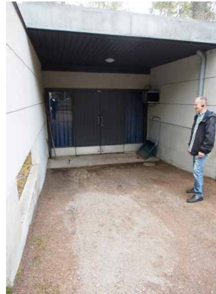
Ruumishuoneen luiska ja katos, Kouvolan Välikankaan siunauskappeli.
