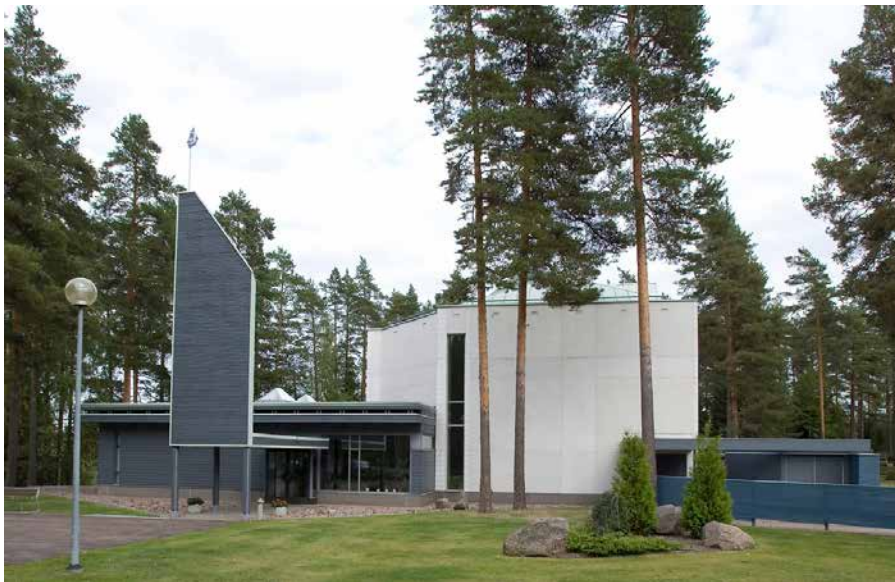
Kuvat yllä: Timo ja Tuomo Suomalaisen suunnittelema Leirikankaan siunauskappeli Haminassa valmistui 1989. Yllä julkisivu lähestymissuunnasta ja oikealla alttari.
