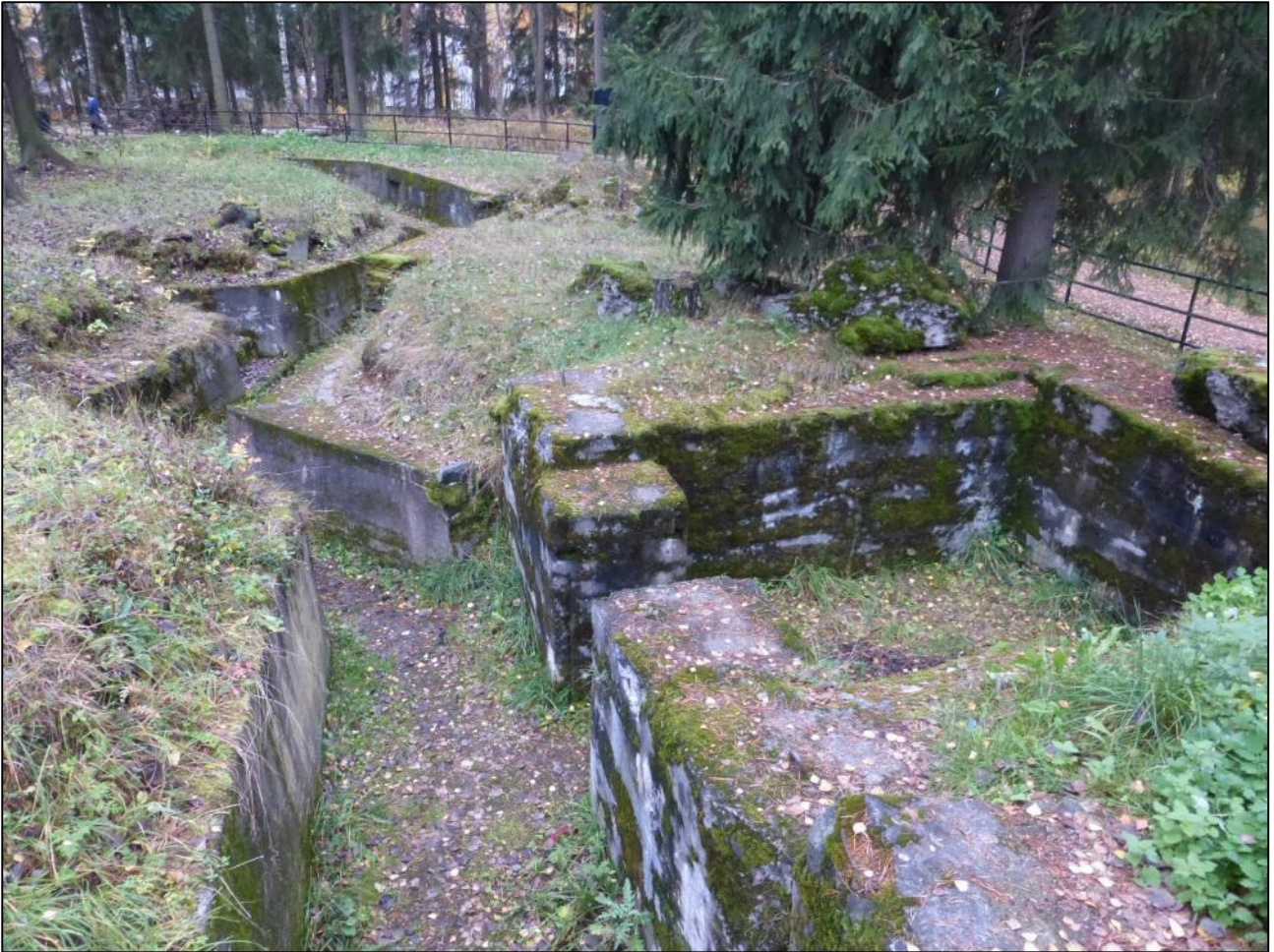
Kallioon louhittuja ja betonoituja taisteluhautoja ja suojahuone Helsingin Paloheinässä (Tukikohta XVII:12). Kuvaaja: Ulla Salmela, Museovirasto.
