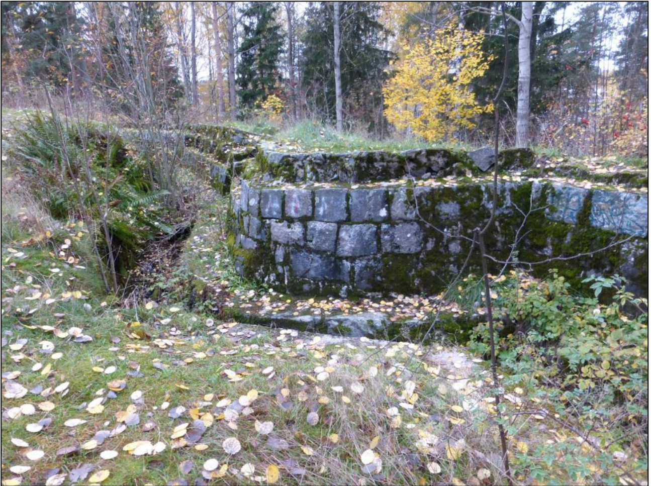
Harkkokivillä tuettu kallioon louhittu taisteluhauta Helsingin Kannelmässä (Tukikohta XX:4). Kuvaaja: Ulla Salmela, Museovirasto.
