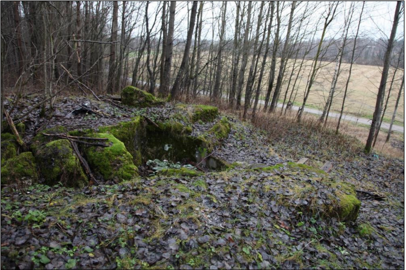
Betoninen konekivääriasema Helsingin Malmin Sepänmäellä (Tukikohta IX:8). Kuvaaja: V.-P. Suhonen, Museovirasto.
