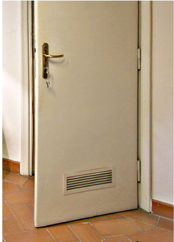
Pesutuvan ovesa on säleiköllä varustettu siirtoilmakaukko.
