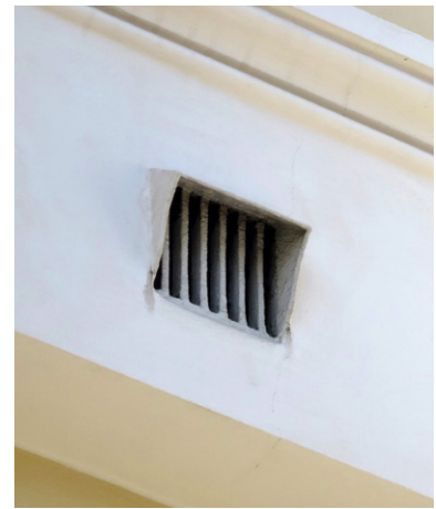
Lipalla varustettu tuloilmakalteri 1800-luvun alkupuoliskolta.
