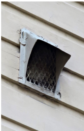
Lipalla varustettu tuloilmakalteri 1800-luvun alkupuoliskolta.
