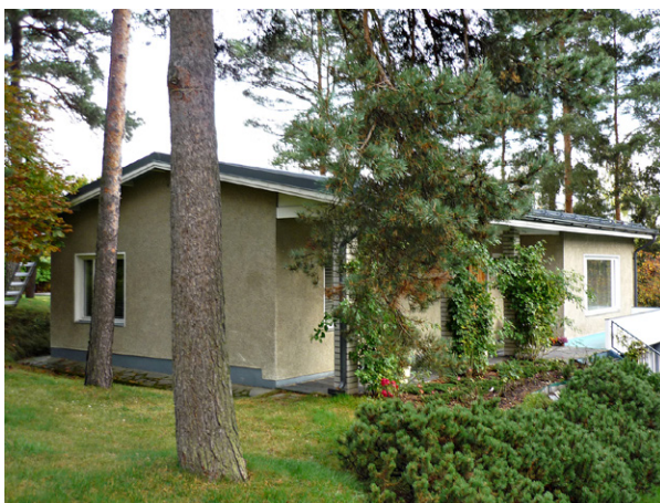
1950-luvulla asuintilat saatettiin jättää kokonaan ilman tuloilmalaitteita. Tämän talon ainoat tuloilma-aukot sijaitsevat kellarisäunassa.
