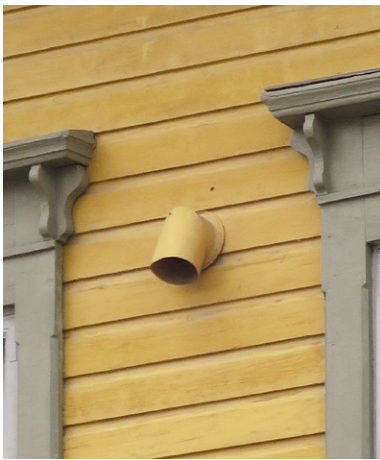
Ennen monimutkaisempien venttiilien yleistymistä hirsitalon raitisilma-aukko voitiin varustaa L-muotoisella putkella, joka oli sisäpuolelta suljettavissa kannella.
