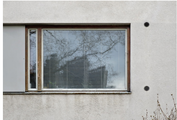
Korkean kylmäkomeron ilma-aukot ikkunan vierellä. Matala kylmäkomero voitiin sijoittaa myös ikkunan alle, ja ilma-aukkoja saattoi olla vain yksi.
