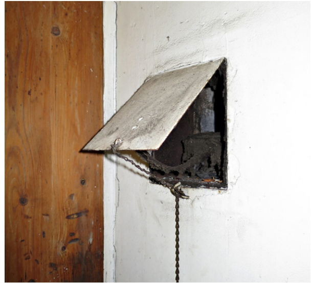
Pitkään suljettuna ollut poistoventtiili on imuroinnin tarpeessa.
