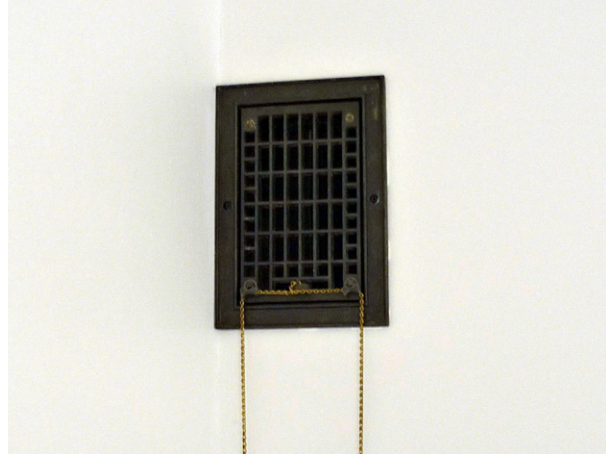
Poistoventtiilinä toimiva valurautainen säleventtiili, joka ei suljettunakaan ole täysin tiivis.
