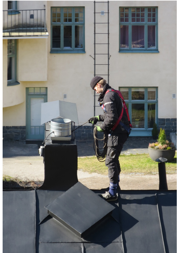
Nuohouksen yhteydessä voidaan kartoittaa hormit ja tutkia niiden tiiveys savukokeella.
