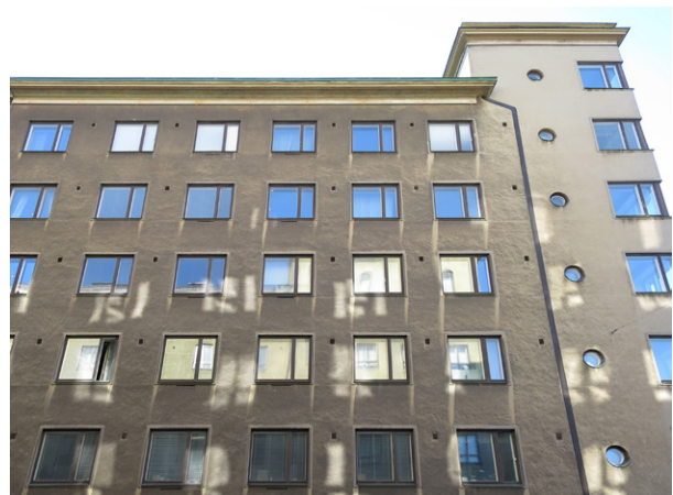
Funkistalon kylmäkomerot on varustettu erillisin seinäventtiilein, mutta muuten tuloilma-aukot on tehty ikkuna-aukkoon yhdistettyinä.
