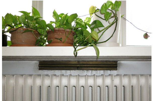
Tavallinen patterisyvennykseen sijoitettu rakoventtiili, joka suljetaan vivusta kääntämällä. Kuva Netta Bök, kuvamuokkaus Livady.
