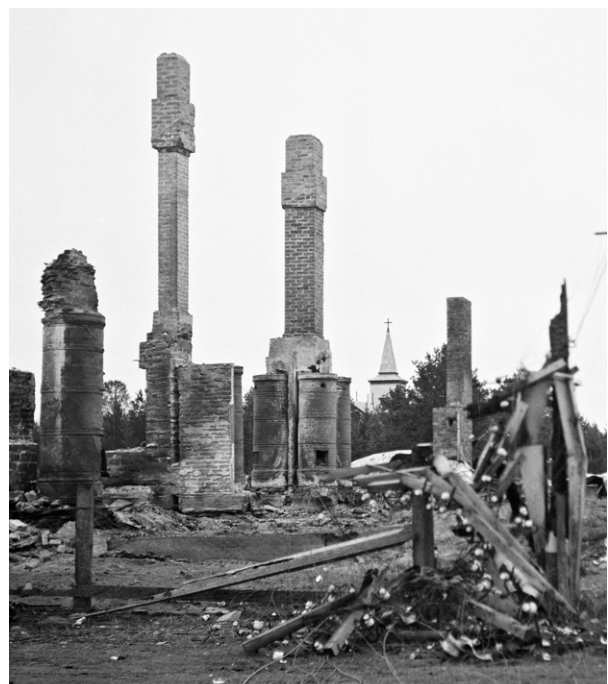
Tiilestä muurattu hormisto on niitä harvoja rakennusosia, jotka voivat kestää jopa tulipalon. Kuva SA-kuva, kuvamuokkaus Livady.
