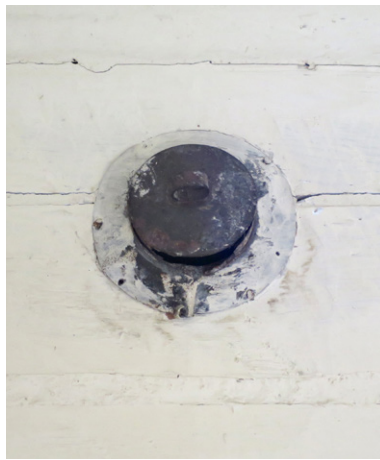
Ennen monimutkaisempien venttiilien yleistymistä hirsitalon raitisilma-aukko voitiin varustaa L-muotoisella putkella, joka oli sisäpuolelta suljettavissa kannella.
