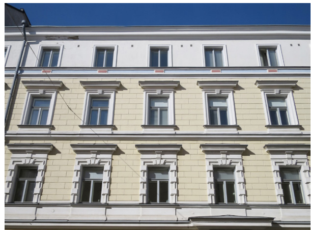
Kerrostalaja rakennettiin jonkin verran ilman tuloilma-aukkoja. Tähän uusrenessanssitaloon on tehty lisäkerros, jonka tilat on varustettu huonekohtaisilla venttiileillä.
