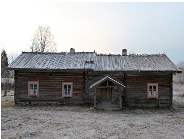
Talonpoikaistaloihin ei yleensä tehty erillisiä tuloilma-aukkoja. Raitista ilmaa saatiin tahattomasti ikkunoiden ja ovien raoista sekä tuulettamalla.
