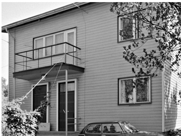
1940-luvulla puutaloissakin käytettiin tuloilmalaitteena ikkunoiden alle sijoitettuja rakoventtiilejä. Kuva Helsingin kaupunginmuseo, kuvaaja C-G. Roos 1976.
