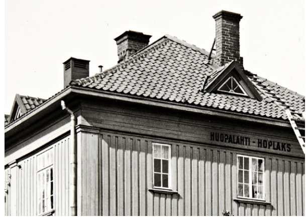
1920-luvulla valmistuneen asemarakennuksen katolla on sekä puu- että tiilipiippuja. Kuvan vasemmassa reunassa näkyy myös julkisivussa oleva tuloilma-aukko. Talossa on painovoimainen ilmanvaihto. Kuva Museoviraston arkisto.
