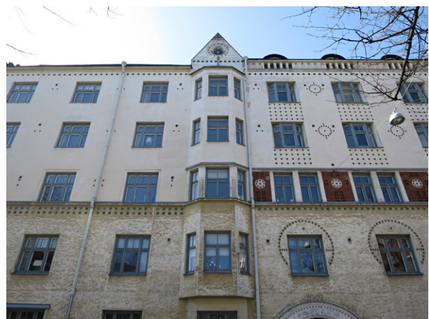
Jugendtaloissa tuloilma-aukot otettiin monesti osaksi julkisivukoristelua.
