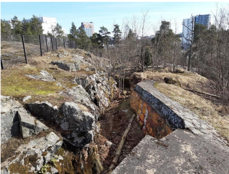
Kuva 4. Ensimmäisen maailmansodan aikainen Helsingin maalinnoituksen Tukikohta XXIX:3 (Pohjois-Leppävaara), jossa kallioon louhittuja taistelukaivantoja. Kuva: Eetu Sorvali, 3338:12, KAMU Espoon kaupunginmuseo.
