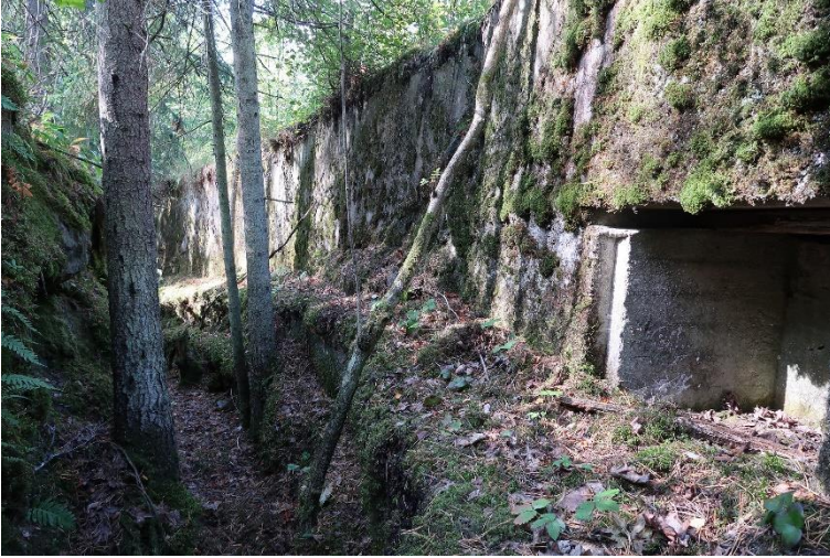
Helsinki Tukikohta I:19 (Mustavuori). Kallioon louhittua taisteluhautaa ensimmäisen maailmansodan aikaisessa linnoitteessa, joka on osa Helsingin maa- ja merilinnoitusta. Markku Heikkinen 2019, G54378, Helsingin kaupunginmuseo.
