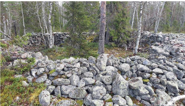
Keminmaa Jatulinlehto. Rakkaan rakennettuja kivirakennelmia sisältävä kohde on ajoitettu vain yleisesti esihistorialliseksi. Kuvassa rakkaan kaivettu ja reunoiltaan kylmämuuraamalla rakennettu kehävalli, joka vastaa pitkälti Tornion Rakanmäeltä tunnettua rakennetta. Titta Kallio-Seppä 2020, Tornionlaakson museo.
