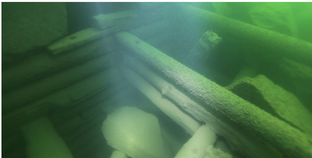
Kuva: Hirsiarkkurakennetta Suomenlinna edustalla. Kuvaaja Maija Huttunen 2011, kuva AKMA201102:79.
