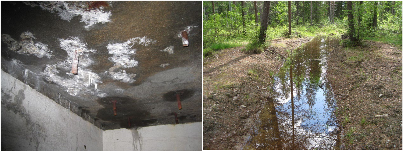
Kuvat 31–32. Linnoituslaitteisiin tihkuva ja kertyvä vesi voi aiheuttaa ongelmia sekä kesto- että kenttälinnoitteissa. Kuvat Päivi Maaranen 2007 ja 2019, Museovirasto.
