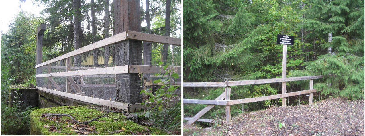
Kuvat 37–38. Puiset kaiteet ovat nopeita rakentaa ja asentaa, mutta ne täytyy uusida suhteellisen lyhyin väliajoin. Kuvat Päivi Maaranen 2019, Museovirasto.
