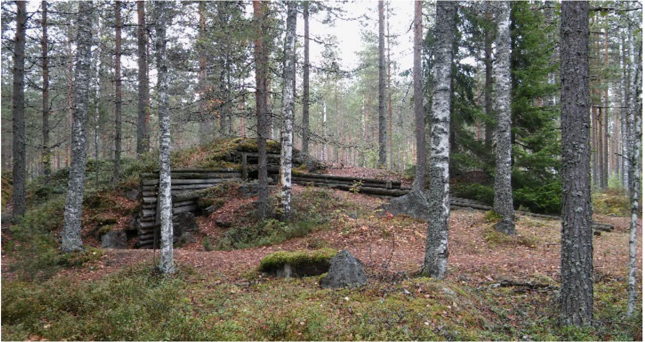
Kuva 1. Maasta, betonista ja puusta rakennettu linnoituslaite. Kuva Päivi Maaranen 2019, Museo- virasto.
