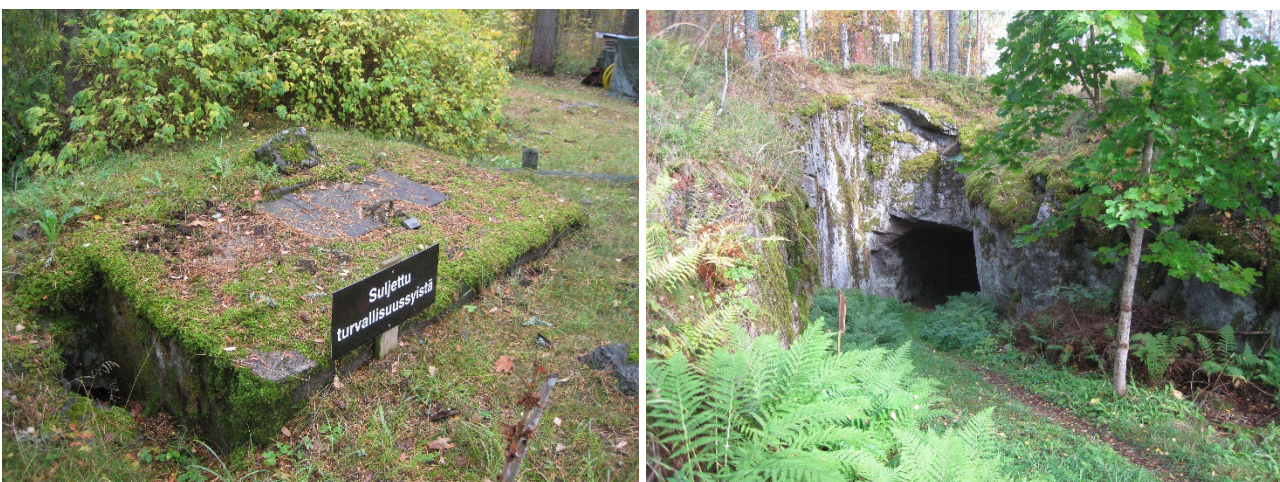
Kuvat 56–57. Luolien aukkojen sulkemusrakennelmat ja kattojen kunto on suositeltavaa tarkistaa riittävän usein, samoin varoituskylltien tila. Kuvat Päivi Maaranen 2019, Museovirasto.
