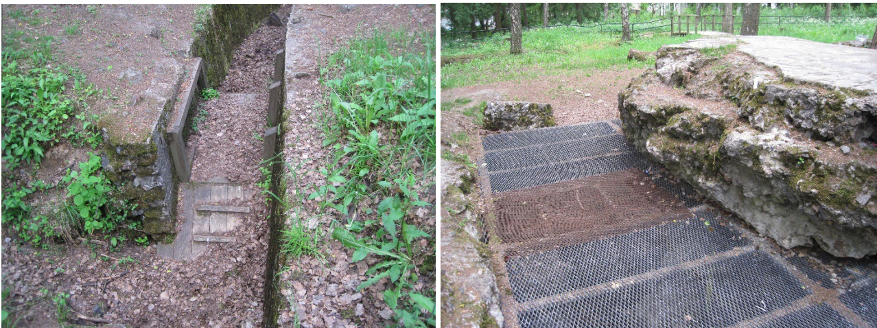
Kuvat 25–26. Yhdysautojen seinämiä tukevat ja romahtamista estävät puurakennelmat sekä murtunutta kattoa tukeva teräsverkko ovat samalla kulkua helpottavia rakennelmia. Kuvat Päivi Maaranen 2020, Museovirasto.
