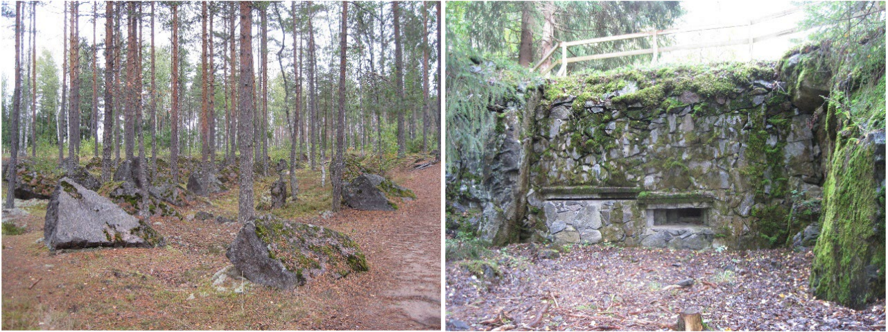
Kuvat 9–10. Kasvillisuudesta raivattuja panssariesteitä ja betoninen kesto linnoite, jonka päällä on puusta tehty, putoamista estävä aita. Kuvat Päivi Maaranen 2019, Museovirasto.
