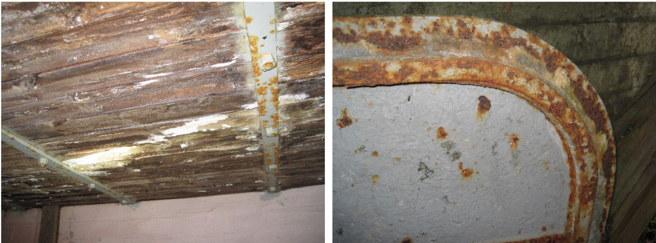
Kuvat 27–28. Linnoituslaitteiden sisätiloissa on monenlaisia materiaaleja ja rakenteita, jotka ovat säilyneet eri tavoin ja tarvitsevat erilaisia korjaustoimenpiteitä. Kuvat Päivi Maaranen 2019, Museo- virasto.
