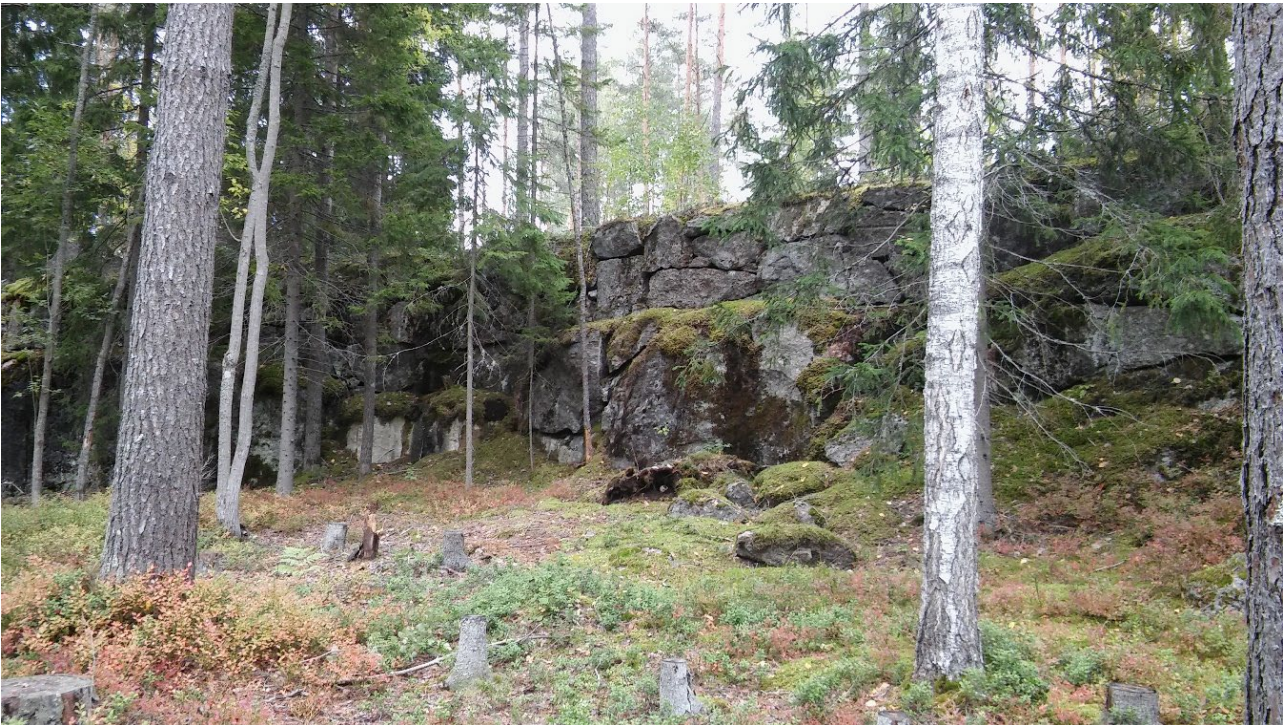
Kuva 45. Maastoon kallion päälle kiven lohkeista rakennettu tehostettu rinneleikkaus on vaarallinen esimerkiksi metsänhakuussa käytettäville työkoneille. Kuva Päivi Maaranen 2019, Museovirasto.
