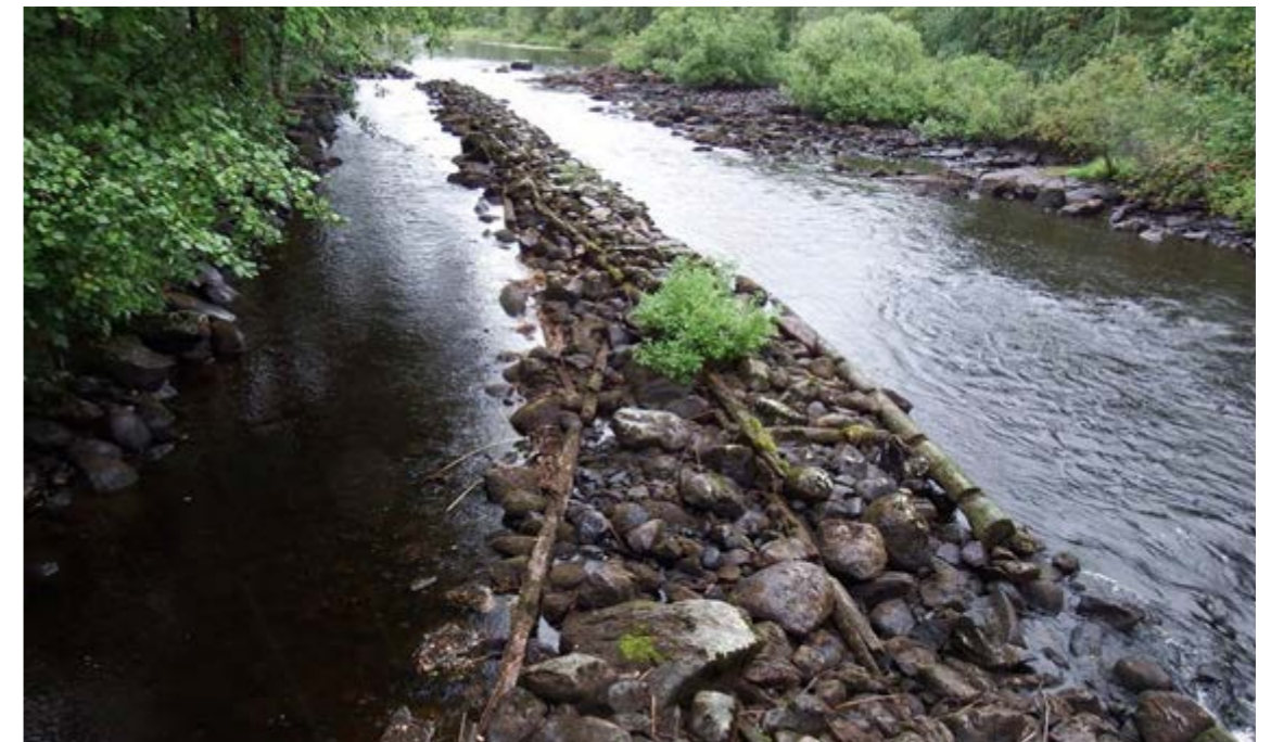
Bild: Dragväg vid Kuurtajankoski i Kuhmo (objekt nummer 1000033134 i fornminnesregistret) fotograferad mot norr. Vid lågt vattenstånd är rester av stockstommen synliga. Vid högt vattenstånd är de inte synliga, vilket gör det svårt eller kanske omöjligt att tolka objektet och beakta det i projekt. Bild: Marika Kieleväinen, Kajanalands museum.
