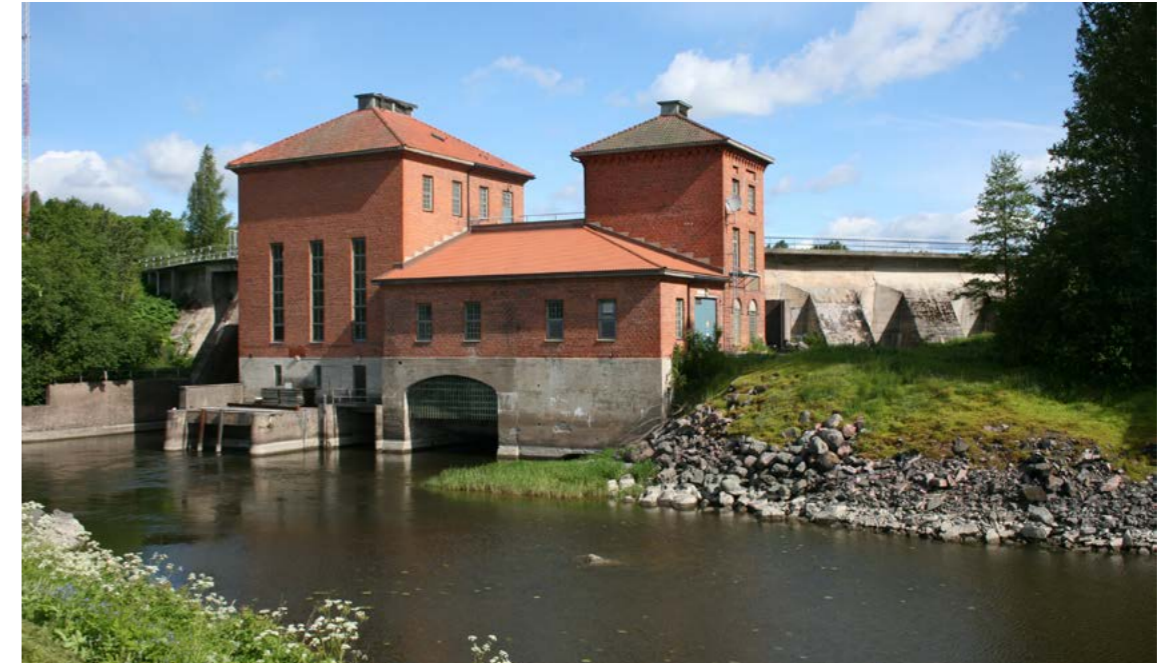
Bild: Åkerfors kraftverk i Svartån, Raseborg. Bild: Maija Matikka, Museiverket.
