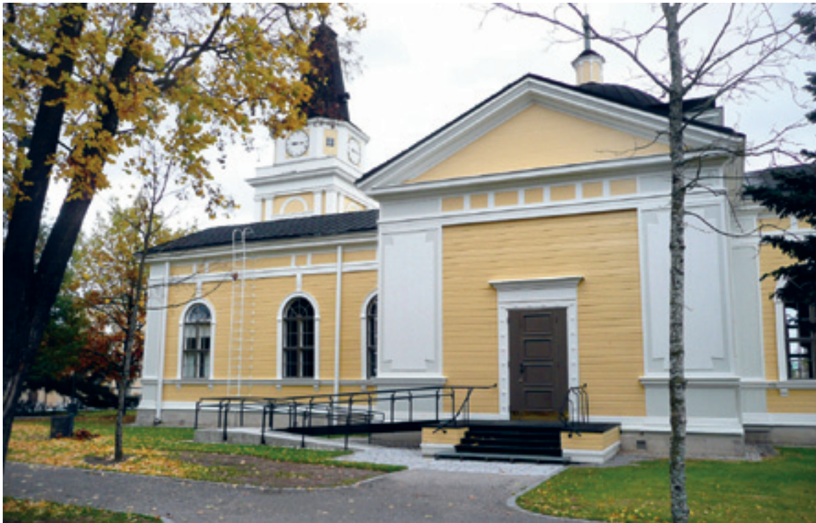
Luiskan alempi osuus tehtiin graniitista ja betonista, ylempi osuus toteutettiin teräsrakenteisena siltana. Portaan puinen tasanne rakennettiin uudestaan nykyistä syvempänä. Kuva Hanna Lyytinen.
