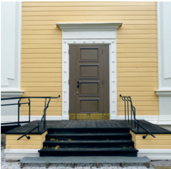
Oviaukon alkuperäinen leveys säilytettiin visuaalisesti samana, vaikka ovi uusittiin kapeampana ja helpommin avattavana. Kuva Hanna Lyytinen.
