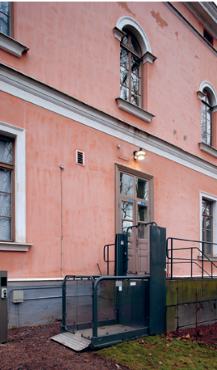
Hakasalmen huvilan sivuportaaseen asennettu nostin on selkeästi uusi tekninen laite. Kuva Museovirasto / Soile Tirilä.
