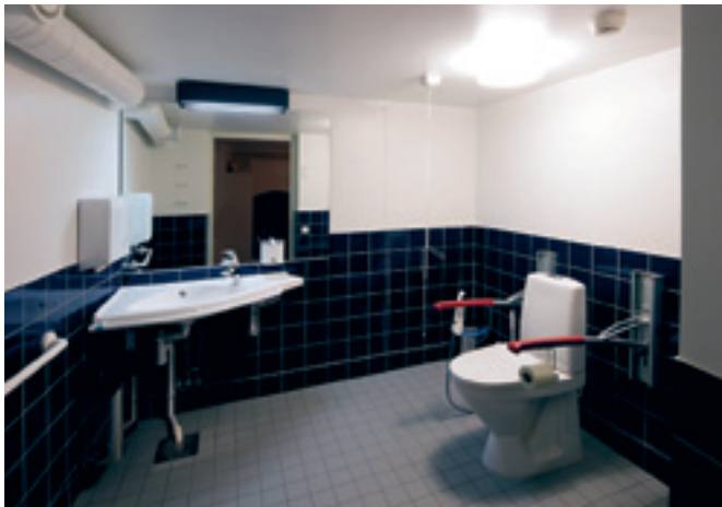
Turun linnaan 2010 toteutettu esteetön wc, jonka tumma alaosa auttaa erottamaan vaaleat kalusteet. Käsisiuhku on sijoitettu wc-istuimen käsitukeen, jolloin siihen ulottuu helposti. Kuva Museovirasto / Soile Tirilä.
