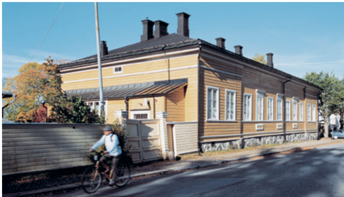
Keittiöpäädyn kuistia pidennettiin, jolloin saatiin tila nostimelle. Aidan taakse kätkeytyvä laajennus erottuu vain kiiltävämmästä kattopelistä. Kuva Museovirasto / Soile Tirilä.
