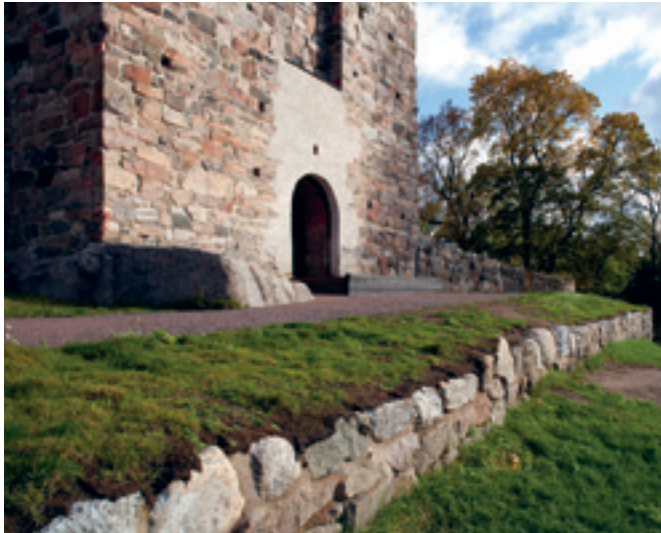
Länsitornin edustan muuria ja maan pintaa korotettiin puoli metriä, jotta luiskista saatiin mahdollisimman loivat. Lopulliset korot määriteltiin vasta rakennuttamisvaiheessa. Kuva Museovirasto / Soile Tirilä.
