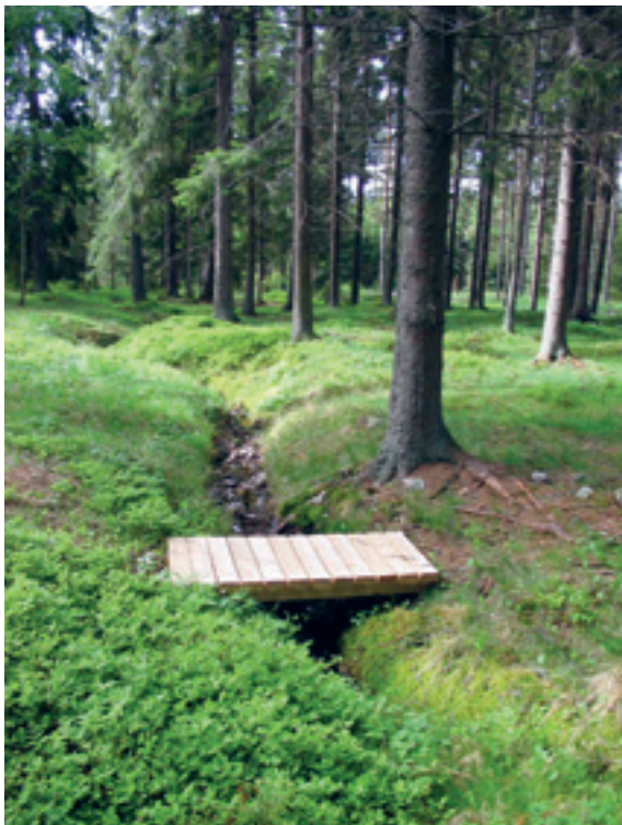
Muinaisjäännöskohteilla on rakennettu liikkumista helpottavia rakenteita, mutta tässäkin kuvassa puron ylittämiseen tehty rakenne on vain noin 80 cm leveä ja näin ollen liian kapea esteettömään liikkumiseen apuvälineiden kanssa. Myös sillan päätyjä tulisi pidentää ja loiventaa, jotta vältytään tasoerolta siirryttäessä polulle. Suojareunat estäisivät pyörän ajautumisen reunan yli. Kuva Museovirasto / Satu Mikkonen-Hirvonen.
