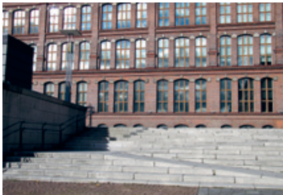
Luiska ja portaikko Keskustorin ja Satakunnankadun välillä. Askelmien reunat ja luiska eivät erotu tummuus-contrastina, mikä hankaloittaa portaissa liikkumista. Kuva Kynnys ry / Niina Kilpelä.
