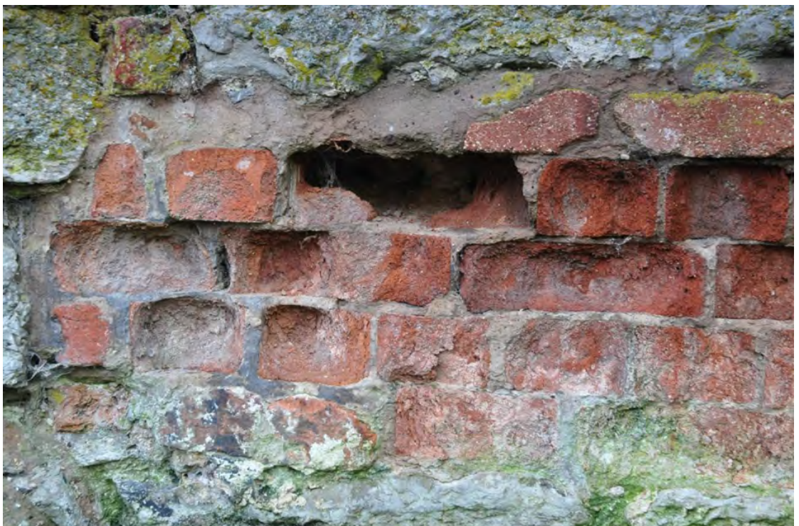
Visby ringmur, cementblandade fogar och vittrat tegel. Foto: Helen Simonsson Riksantikvarieämbetet CC-BY.
