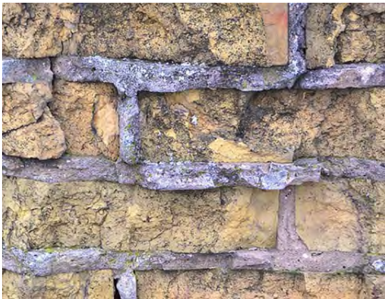
Felaktigt materialval. Användandet av cement i fogbruket har här bidragit till att det mjukare teglet frostsprängts. Foto: Helen Simonsson, Riksantikvarieämbetet CC-BY.
