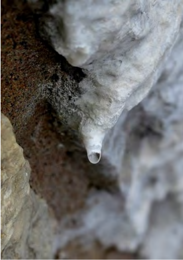
Vatten transporterar salt till ytan. Visby ringmur. Foto: Helen Simonsson CC-BY.
