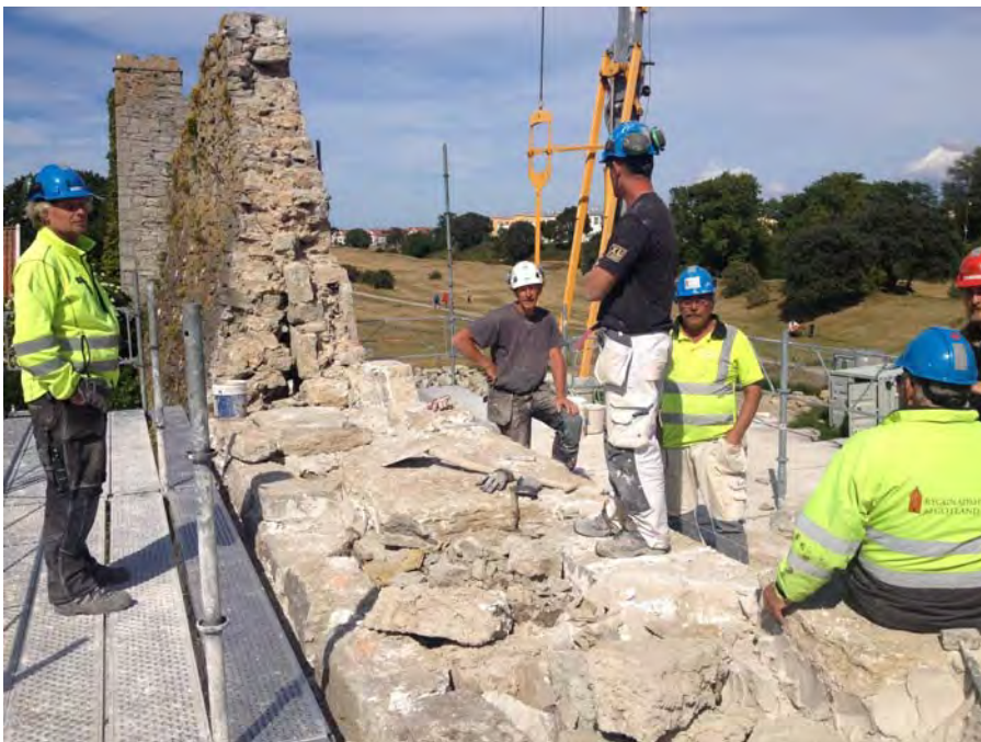
Hantverkarna från Byggnadshyttan håller rådslag vid den pågående återuppbyggnaden på muren. I den öppna muren ses stora bindstenar som binder ihop skalen med kärnan. I det öppna snittet på originalmuren syns den övre delen av bröstningsmuren och hur murförhöjningen byggts på mot denna. Man ser även hur de översta krönskiften, som inte är bredare än ca 80 cm, är byggda som fullmur. Foto: U.Mebus
