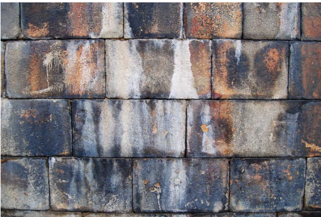
Vatten transporterar salt till ytan. Visby ringmur. Foto: Helen Simonsson CC-BY.
