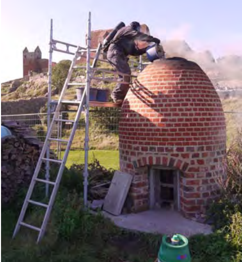
Kalkovn hvor der brændes kalk til restaureringsmørtel.
