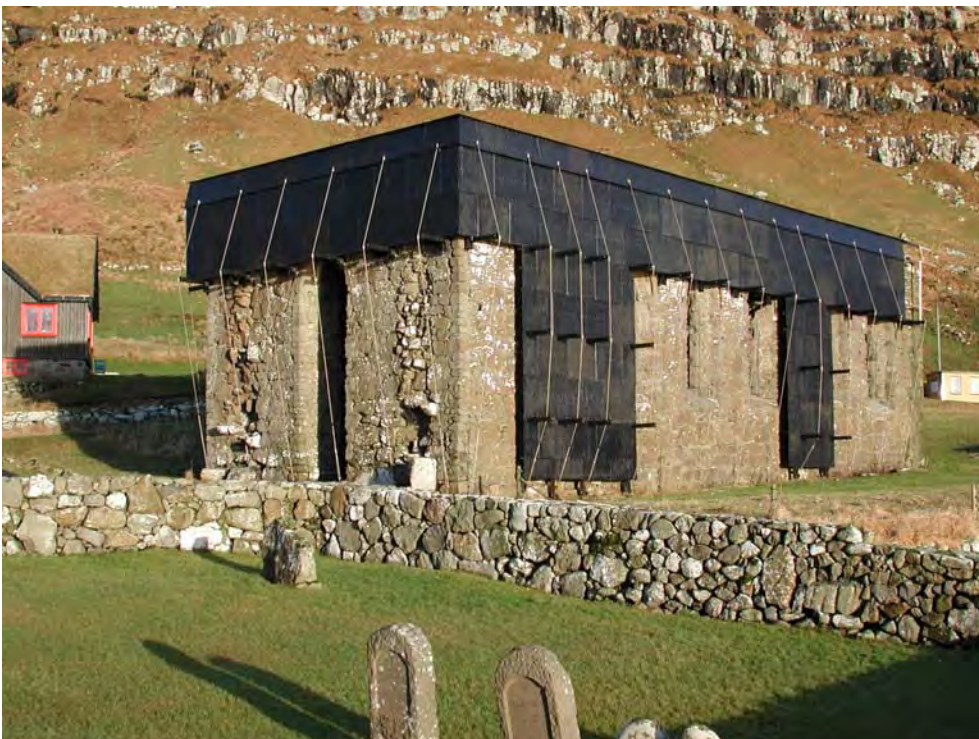
Fig. 2 Domkirkeruinen, overdækket med klimaskærm 2005. Foto S. V. Arge
