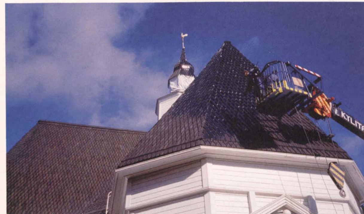
Paanukattoja tervattaessa on kattopinnan oltava kuiva, sateella tai kostealla ilmalla ei tervausta saa tehdä. Terva harjataan kattopintaan voimakkaasti hiertäen, kuten Ylihärman kirkossa kuulakkaan koleana syyskuun päivänä.
