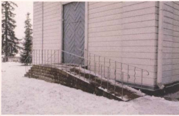
Myrskylän kirkon kiviportaassa liikkumisesteisten luiska on sijoitettu portaan toiseen sivuun. Luiskan ja kirkon seinän väliin on jätetty riittävästi tilaa, ettei luiska aiheuta seinän mädäntymistä.
