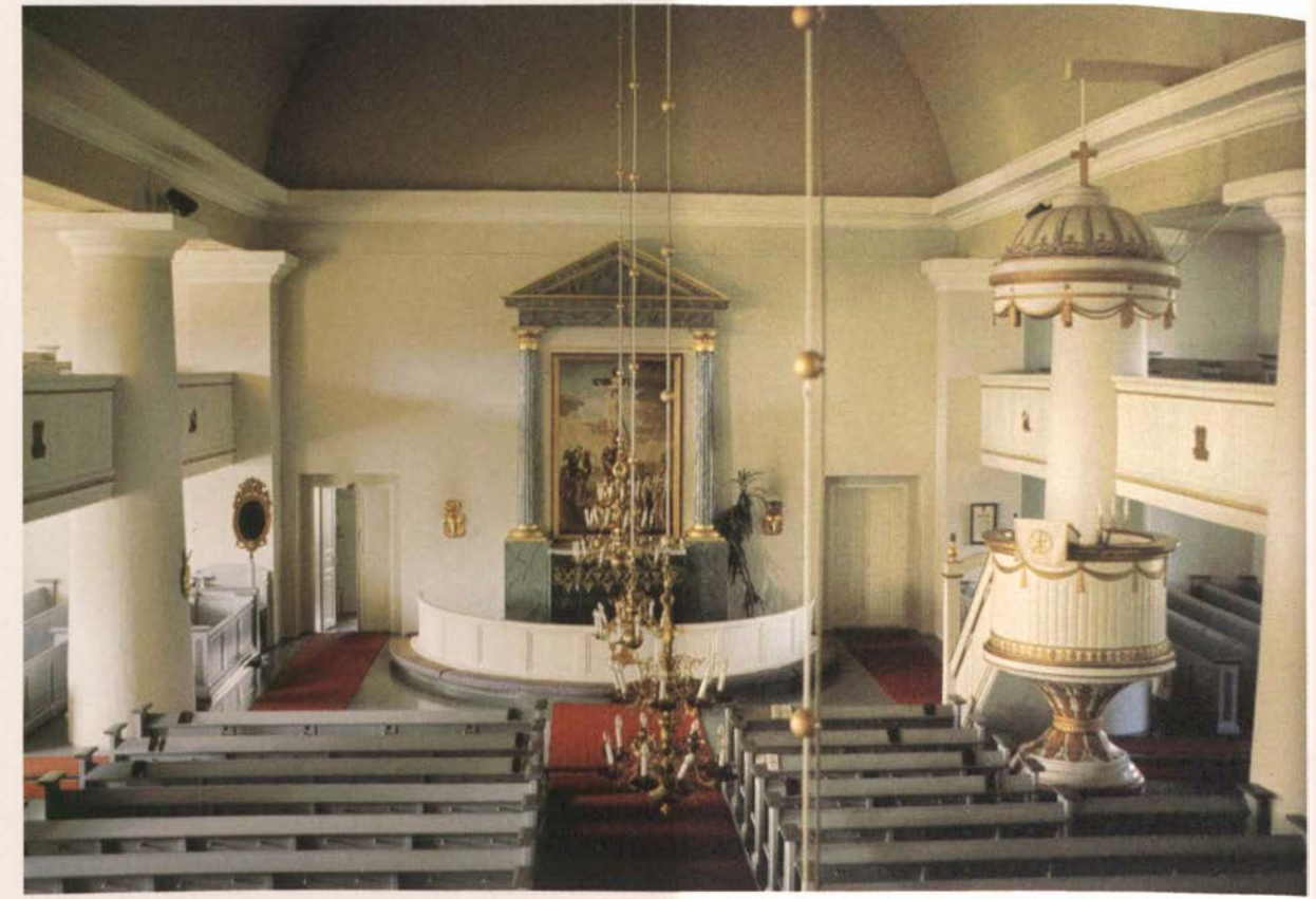
Suomen intendenttikonttorin esimiehen, arkkitehti C.L. Engelin piirtämän Kemninan kirkon vaaleaa ja valoisaa sisätilaa reunustaa pylväiden kannattama lehterikerros.
