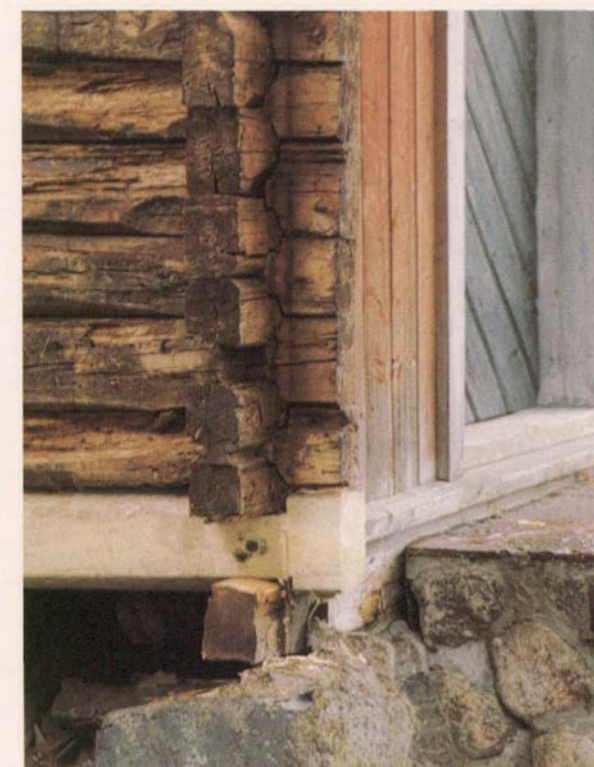
Puukirkkoa kengitettäessä on kivijalkaa purettava tarpeen vaatiessa, jotta korvaava hirsi saadaan varattua tukevasti paikalleen.
