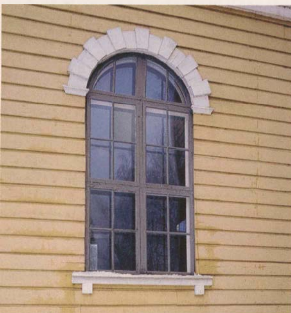
Ikkunat ovat oleellinen osa kirkkorakennuksen ulkoarkkitehtuuria. Niiden uusiminen on harvoin tarpeellista, vanhojen kunnostuksella ja hoidolla kirkon ilme säilyy.
