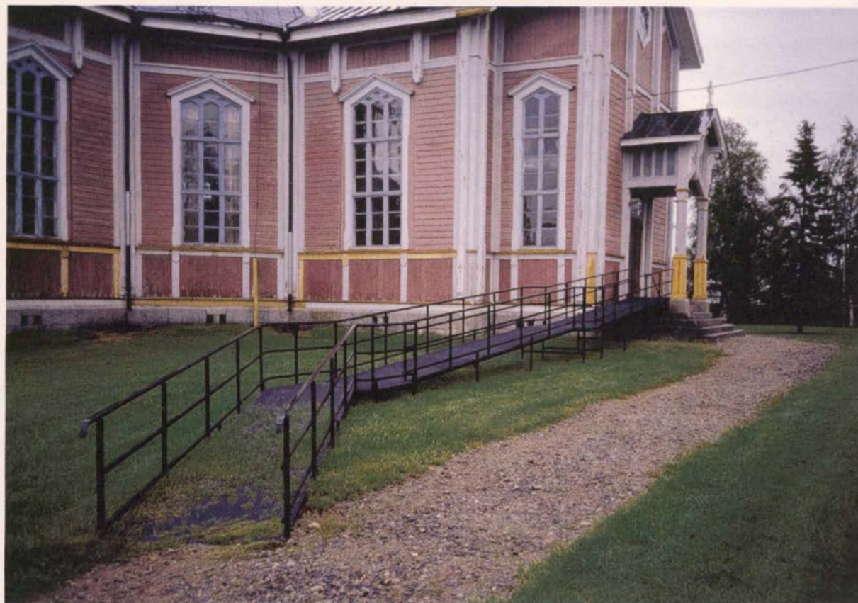
Rakentamismääräysten mukaisen kaiteella varustetun loivan liikkumisesteisten luiskan sovittaminen kirkkoon saattaa olla hankala tehtävä.
