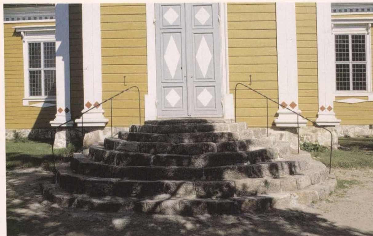
Korkea kivijalka on kirkon alapohjan tuulettumisen kannalta edullinen. Kivijalan korkeus tuo kuitenkin tullessaan moniaskelmaiset portaat sisäänkäyntien eteen. Honkajoen kirkossa kulkua on helpotettu kaitteilla.
