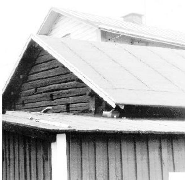
Мягкие кровельные рулонные материалы широко используются для устройства покрытий. В особенности, это относится к способу покрытия "по треугольным рейкам", который можно уже отнести к традиционным в строительстве
