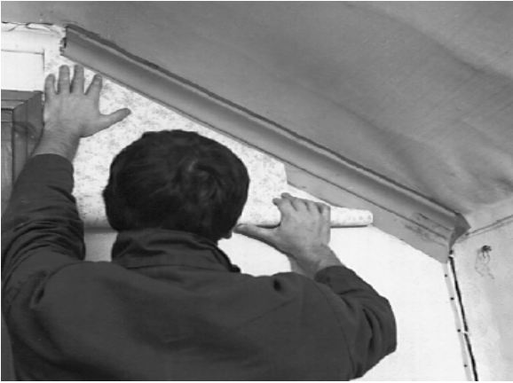
После высыхания исправленного картона, плинтус можно красить, а стену оклеивать обоями или красить
