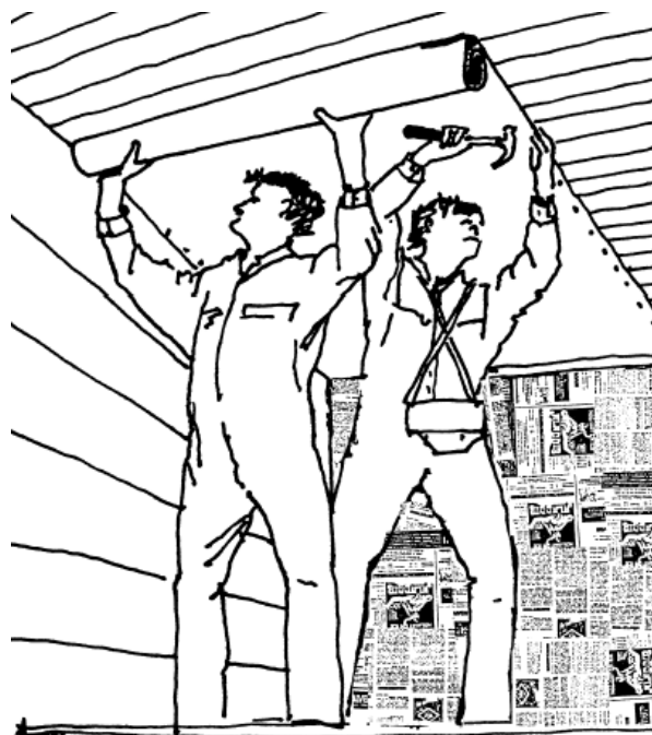
Крепление картона к потолку
