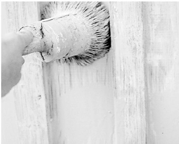
Если используются цинковые белила, они должны быть прозрачными, как показано на этой фотографии. Промежуточное окрашивание здесь только начинается. Этот слой также должен быть тонким. Справа виден отпечаток круглой кисти. Именно пустота в центре дает возможность наносить краску тонким слоем на большую поверхность. На этой стене 1 литр масляной краски покрыл 15 М<sup>2</sup>.
