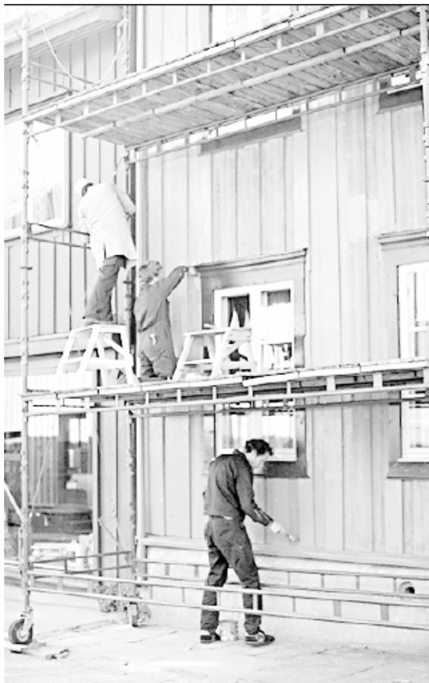
Малярные работы лучше всего производить со строительных лесов. Рабочие настилы лесов нужно на ночь ставить вертикально, чтобы в случае дождя брызги не летели на стены. Вода не проникнет сквозь слой свежей масляной краски, но сделает поверхность неровной и матовой.
