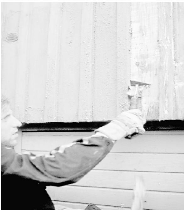
Со стены соскабливают алкидную краску, которая предварительно была намазана средством для снятия красок. Для того, чтобы собрать отходы, вплотную к стене расстилается полиэтиленовая пленка. После соскабливания поверхность зачищается наждачной бумагой. Этот способ лучше, чем мытье под давлением, так как после мытья стена оставалась бы влажной несколько недель.
