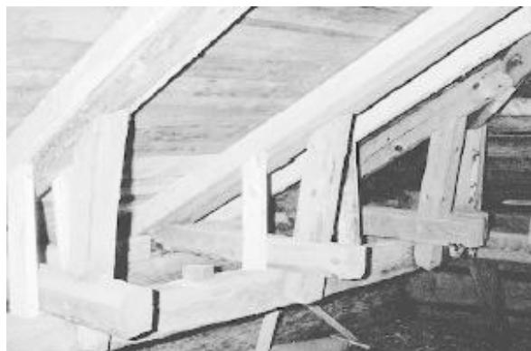
Деревянные конструкции можно укрепить подпорками. Пораженные места не стоит без необходимости чересчур открывать. Если кровля будет отремонтирована, то конструкции высохнут и гниение дерева прекратится. Старые стропила поддерживаются толстыми досками – таким недорогим способом конструкции приведены в порядок. Хозяйственная постройка усадьбы Виксберга в Паймио.
