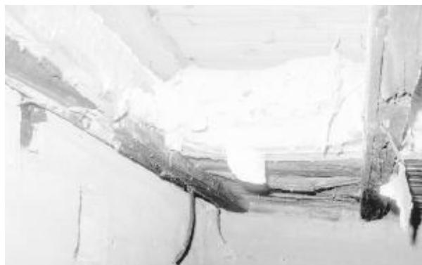
Отверстия для проветривания нижних помещений должны быть открыты в летнее время! Из-за закрытого вентиляционного отверстия влага стала причиной загнивания утепляющего слоя. Опилковая засыпка обваливается. Необходимо периодически проверять состояние конструкций в нижней части здания.
