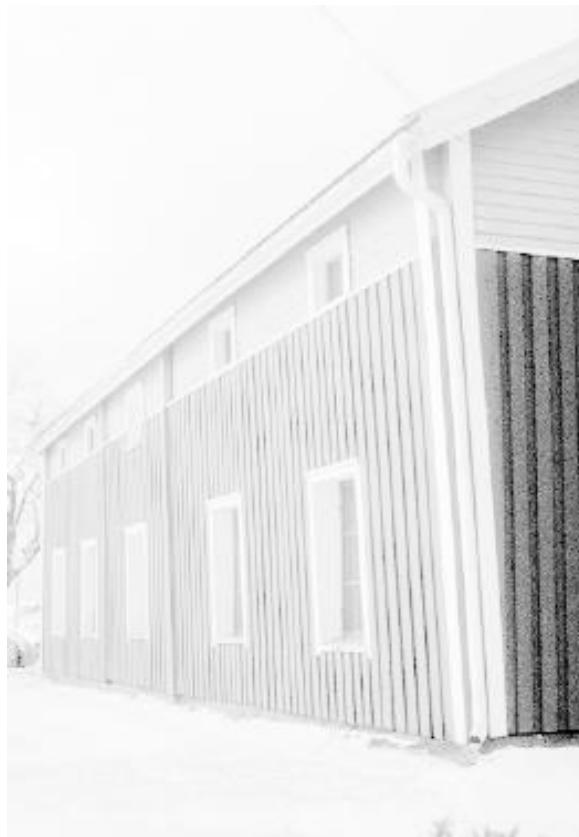
Дополнительная наружная изоляция изменяет фасад, уничтожая его первоначальный материал и красоту. Погрузившиеся в углубления, выкрашенные в прозрачно-коричневый цвет окна и непропорционально укороченные свесы крыши исказили облик крестьянского дома.
