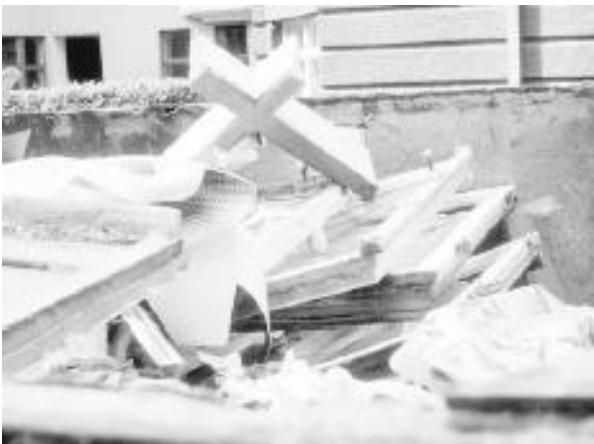
Места для свалки мусора заполнены хорошими окнами, распиленными на части. Такой ремонт окон дело дорогое и мода, разрушающая исторические ценности. Старые окна почти без исключения можно отремонтировать, затратив лишь часть из тех средств, которые уходят на полную замену окон. Кроме того, они сделаны из хорошей древесины и более долговечны, чем новые.
