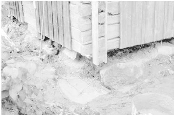
Бревенчатая постройка нуждается в хорошем фундаменте только под углами и перерубами. Если фундамент оседает, то достаточно сделать под углами новые прочные каменные столбики. Здесь мы видим залитый под угол бетонный фундамент, на который будет положен видимый снаружи камень. Одновременно заменяется сгнившее нижнее бревно. Дворовая постройка усадьбы Якари.
