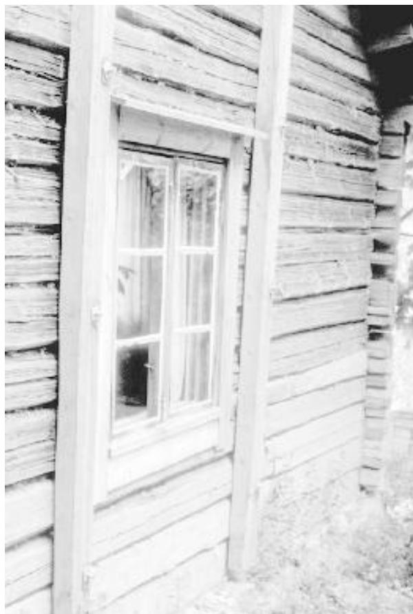
Полностью сгнившие нижние бревна заменены, а стена приподнята и укреплена сжимами. Таким простым традиционным способом был спасен старый деревянный дом. В торпе Хенриксфорс одновременно утеплили стены. Для этого изнутри поверх обветшавшего стеклового картона прибили инсалайт, который покрыли бумагой, окрашенной по старым образцам.
