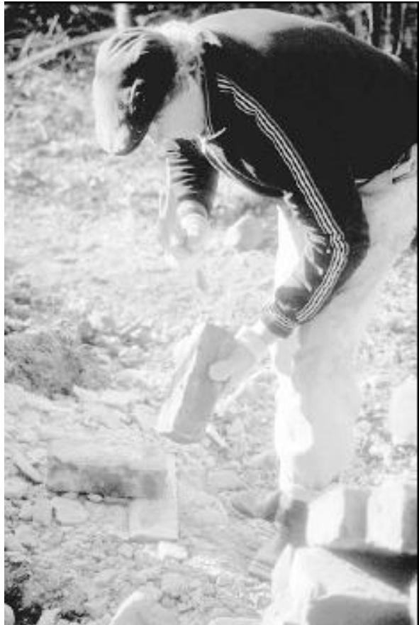
В последние годы, во времена господства разрушительного строительства, было забыто о повторном использовании строительных материалов. Когда, например, нужно ремонтировать поврежденную морозным пучением кирпичную стену, было бы без сомнения разумнее использовать вывалившиеся кирпичи, чем заказывать из магазина новые, а старые вывозить на свалку. В Эспо в Руллудди кирпичи после разборки очищаются для того, чтобы их использовать и в дальнейшем.
