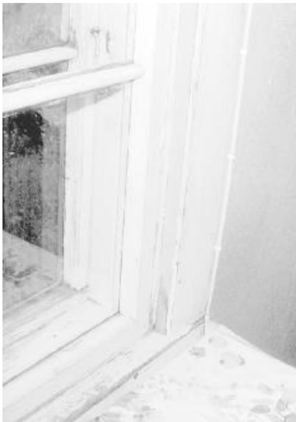
Прибив с внутренней стороны стены инсалайт, можно заметно улучшить ее непродуваемость и утеплить поверхность. Стена утолщается совсем незначительно, что не создает проблем, например, для установки труб. Старые наличники прибивают поверх плиты. Ремонт 1940-х гг. дома в Тервяярви в Соткамо.
